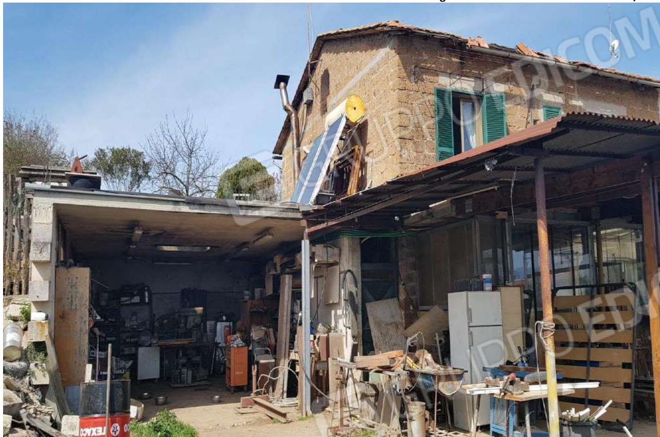
FOTO 5: Veduta esterna prospetto posteriore da part. 202
