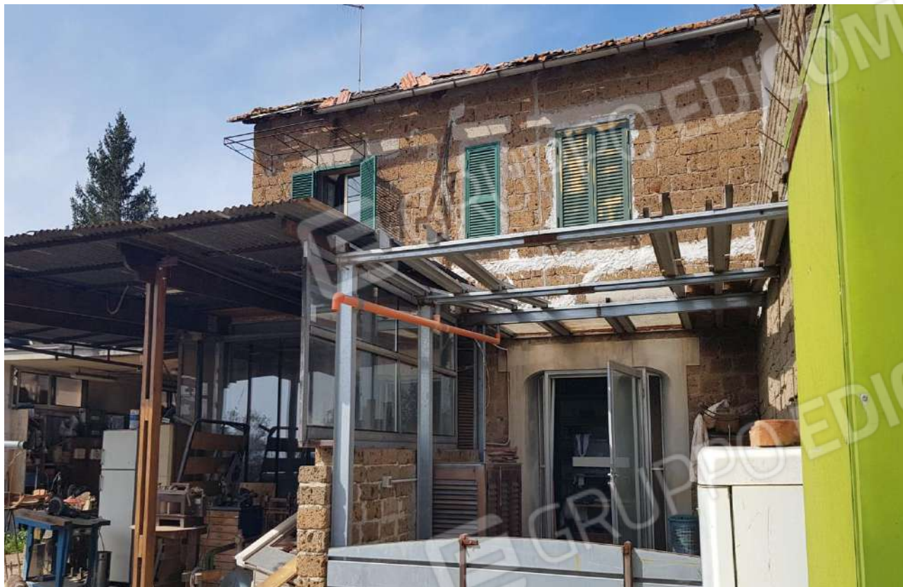
FOTO 3: Veduta esterna prospetto posteriore da part. 202
