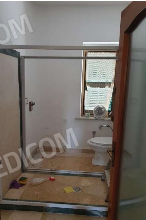
FOTO 11: Veduta interna bagno piano T sub. 2
