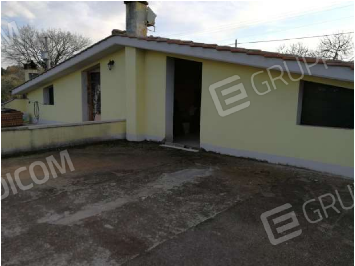
FOTO 10 – Unità Immobiliare “B” – Terrazzo 02
