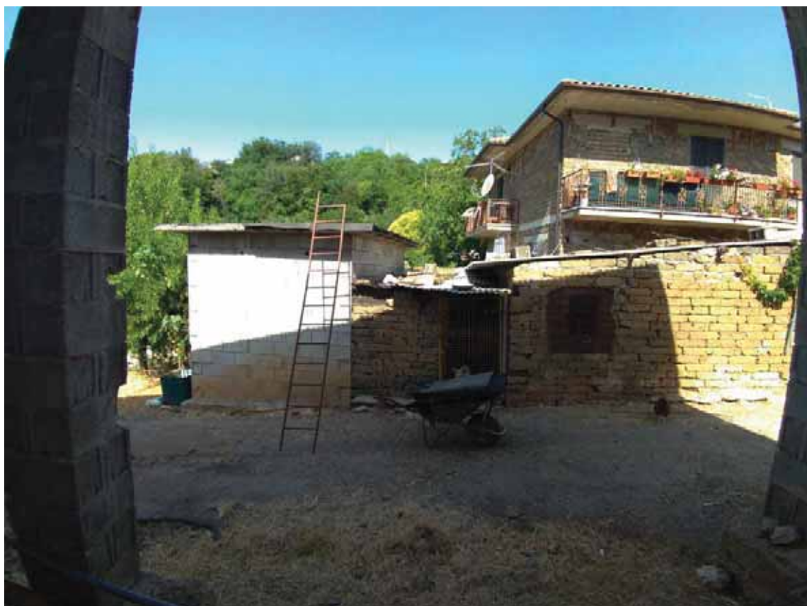
Foto n. 6 Pertinenza Wc- Porcilaia-Magazzino LOTTO 001
