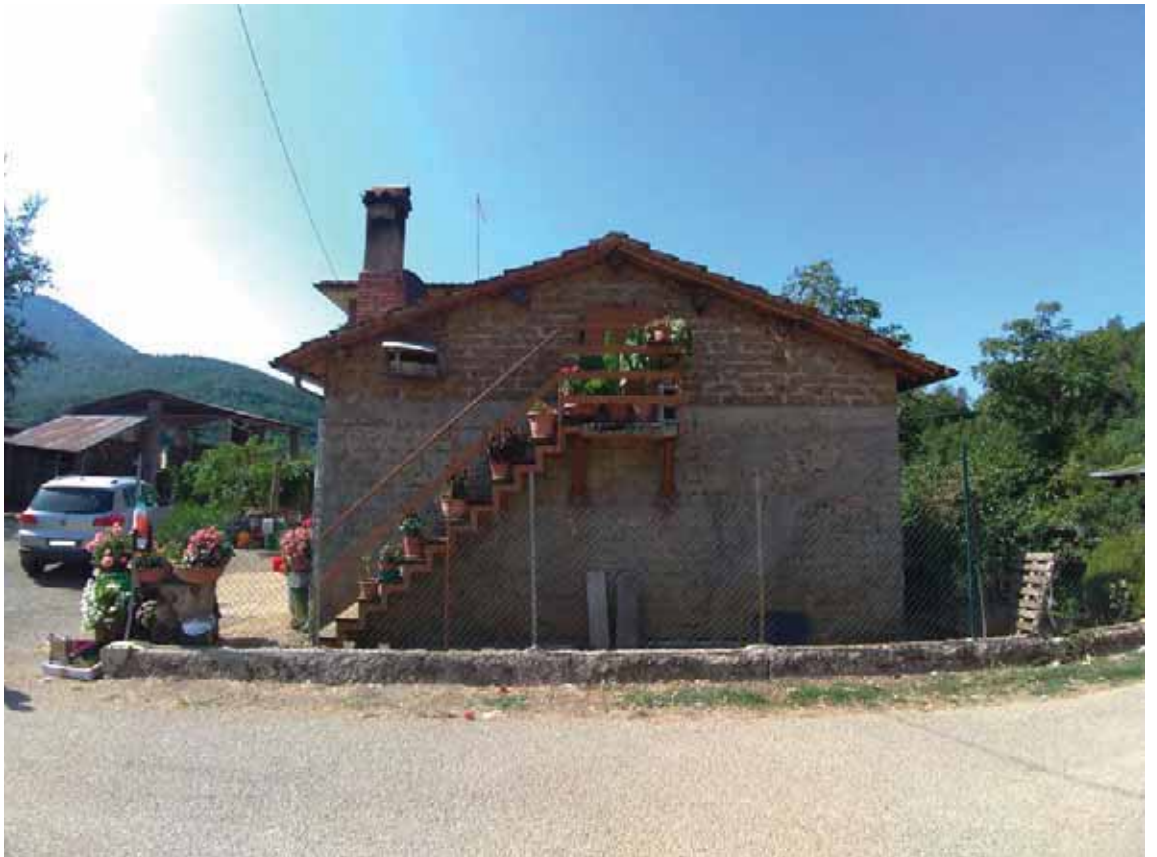
Foto n. 3 Esterno del Fabbricato Prospetto Nord LOTTO 001
