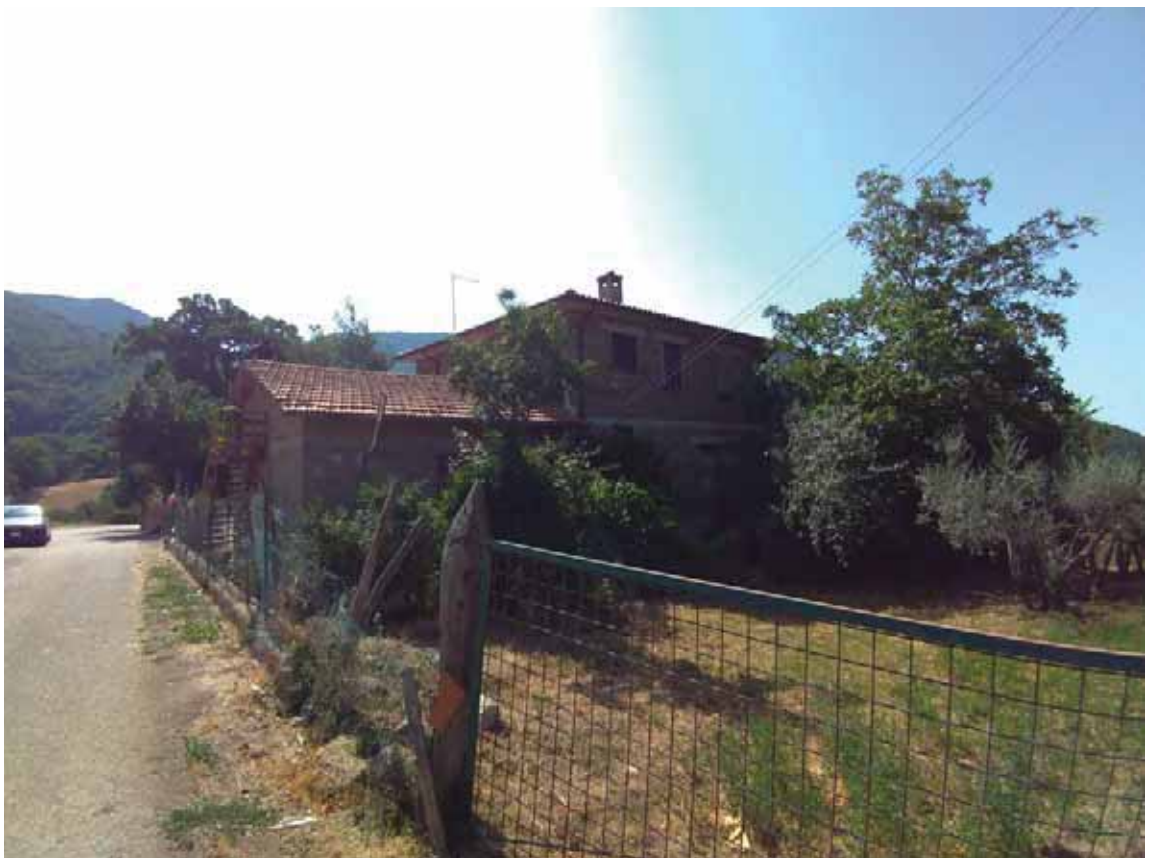
Foto n. 4 Esterno del Fabbricato Prospetto Ovest LOTTO 001
