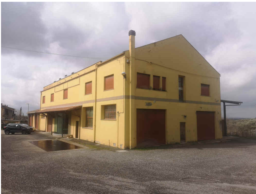
Foto n. 1 – Prospetto del fabbricato lato sud-est
