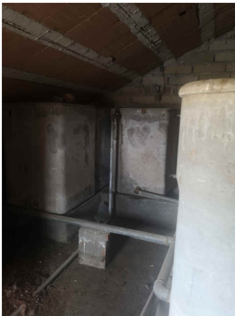
Foto n. 22 - Serbatoi in eternit al piano sottotetto
