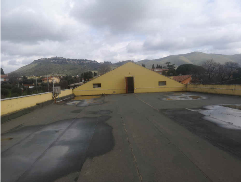
Foto n. 20 - Copertura a terrazzo al Piano Secondo
