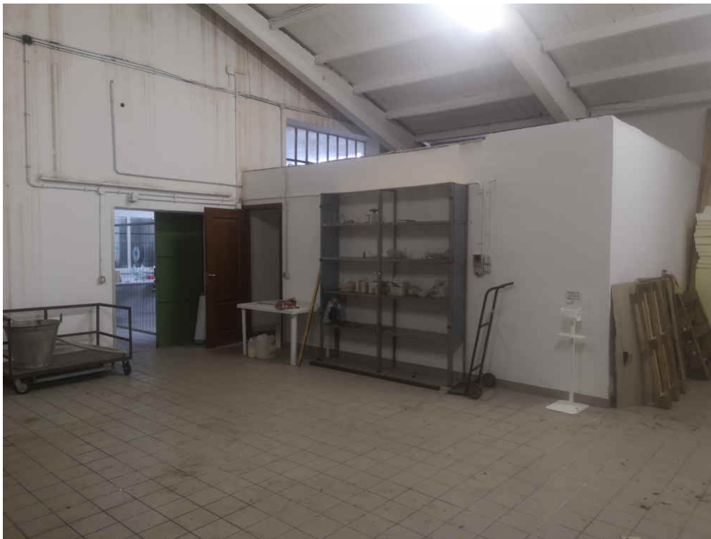
Foto n. 14 - Magazzino al Piano Terra
