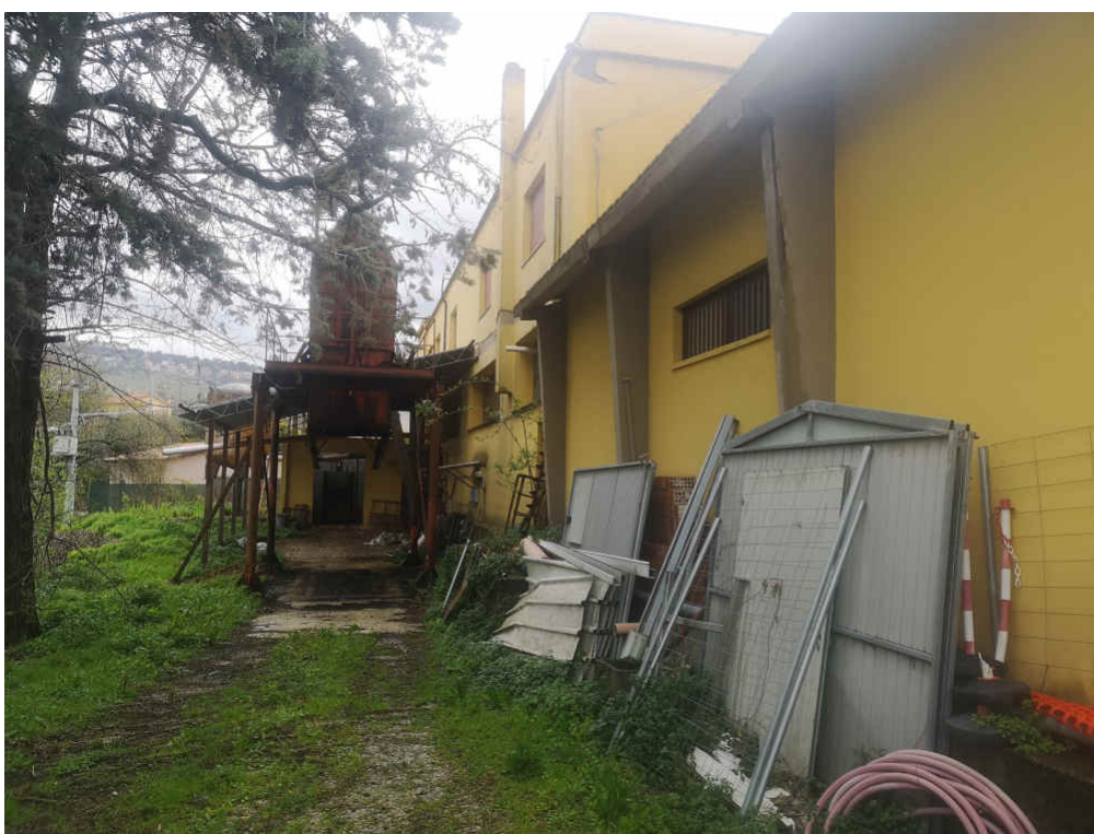
Foto n. 3 - Prospetto del fabbricato lato nord-ovest
