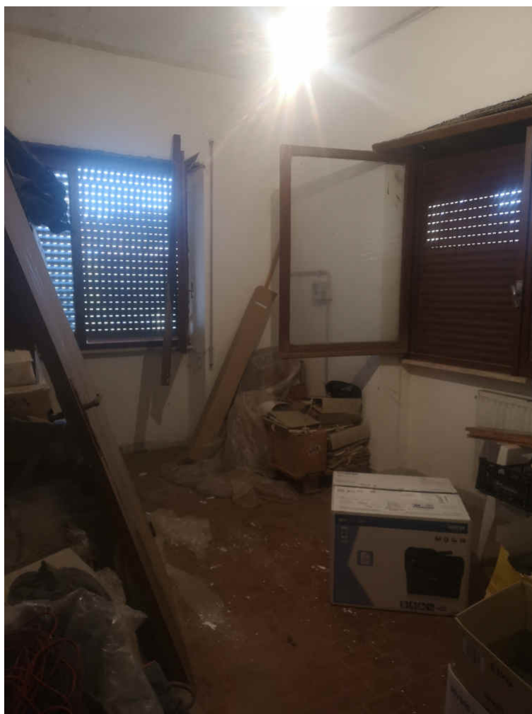
Foto n. 19 - Deposito al Piano Primo
