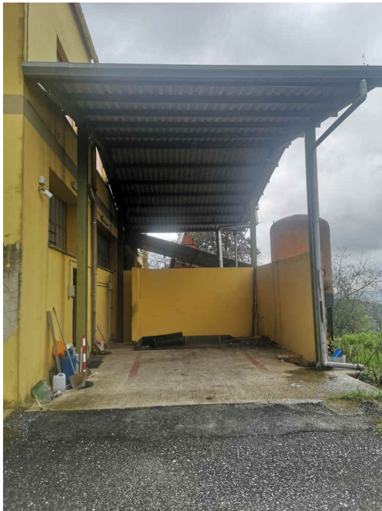
Foto n. 4 – Prospetto del fabbricato lato nord/est
