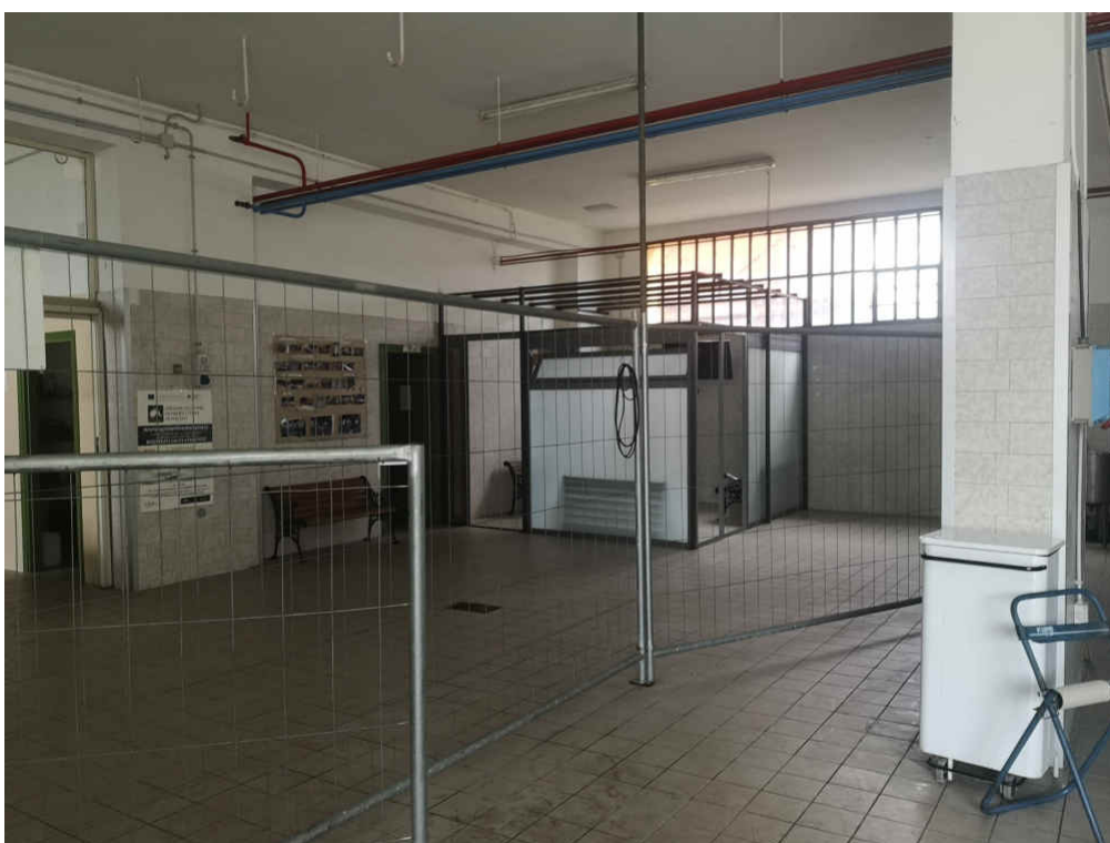
Foto n. 9 - Sala frantoio al piano terra
