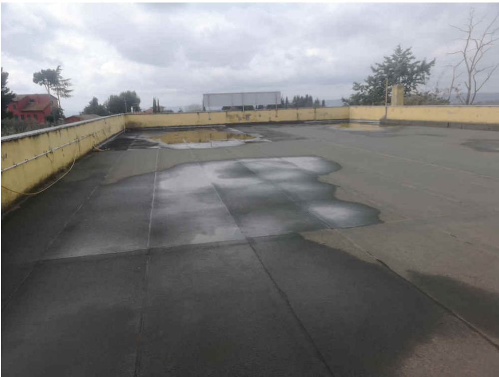
Foto n. 21 - Copertura a terrazzo al Piano Secondo
