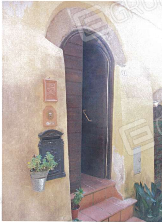
Vedute esterne del fabbricato – ingresso da vicolo Cairoli
