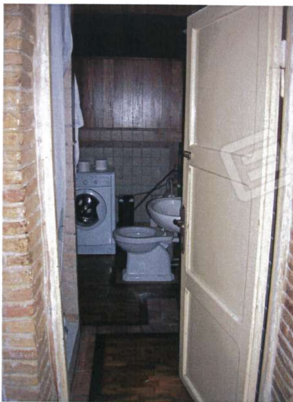
Vedute interne – bagno al piano secondo
