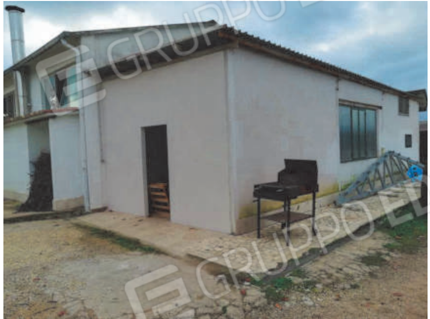
Foto 4 – Vista esterna – Prospetto sud/est
