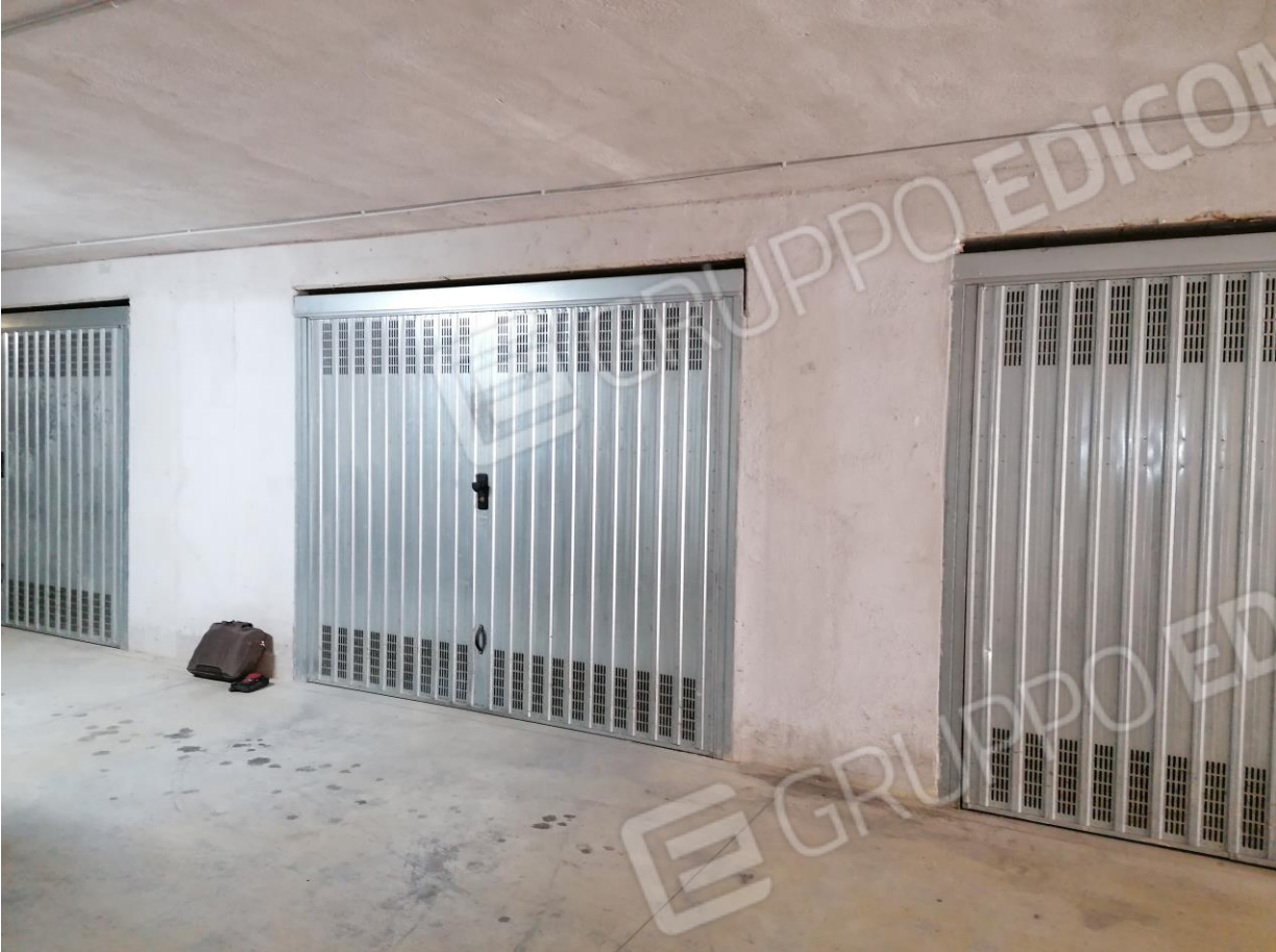
FOTO N°32: Accesso al Corpo E – Piano Sottostrada.
