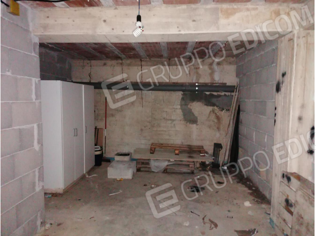
FOTO N°34: Corpo E – Garage – Piano Sottostrada (2/2).
