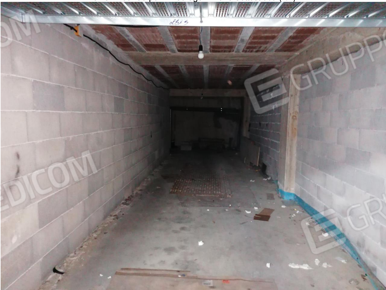
FOTO N°33: Corpo E – Garage – Piano Sottostrada (1/2).
