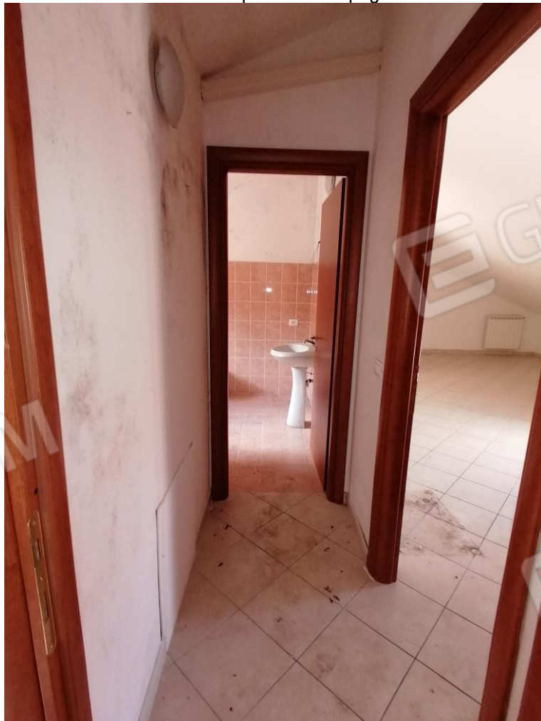
FOTO N°25: Corpo C – Disimpegno – P3.
