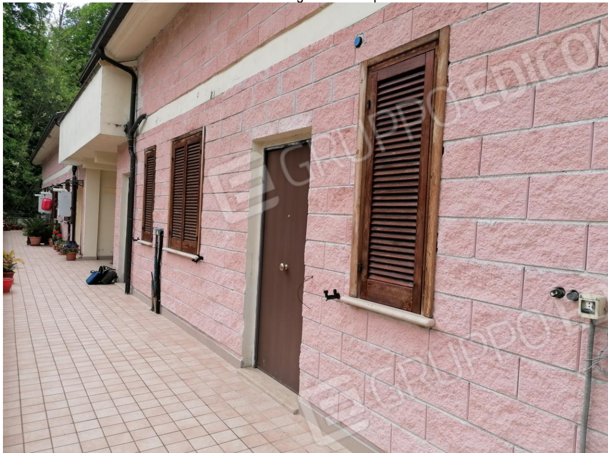
FOTO N°01: Ingresso al Corpo A.
