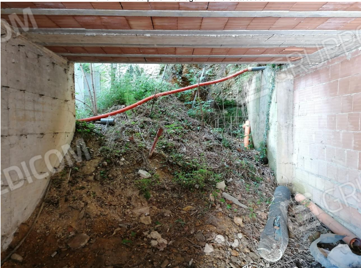
FOTO N°39: Corpo G – Garage – Piano Sottostrada.
