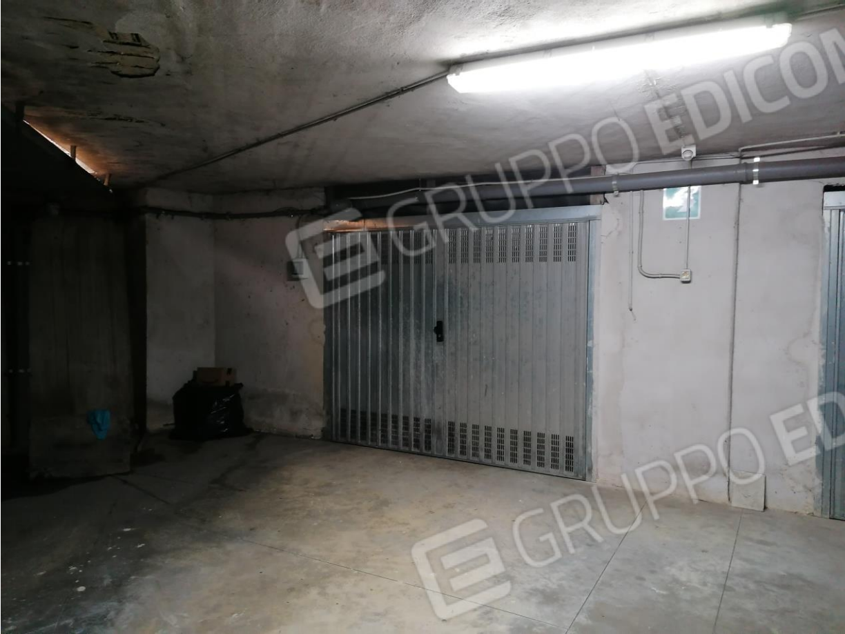
FOTO N°35: Accesso al Corpo F – Piano Sottostrada.
