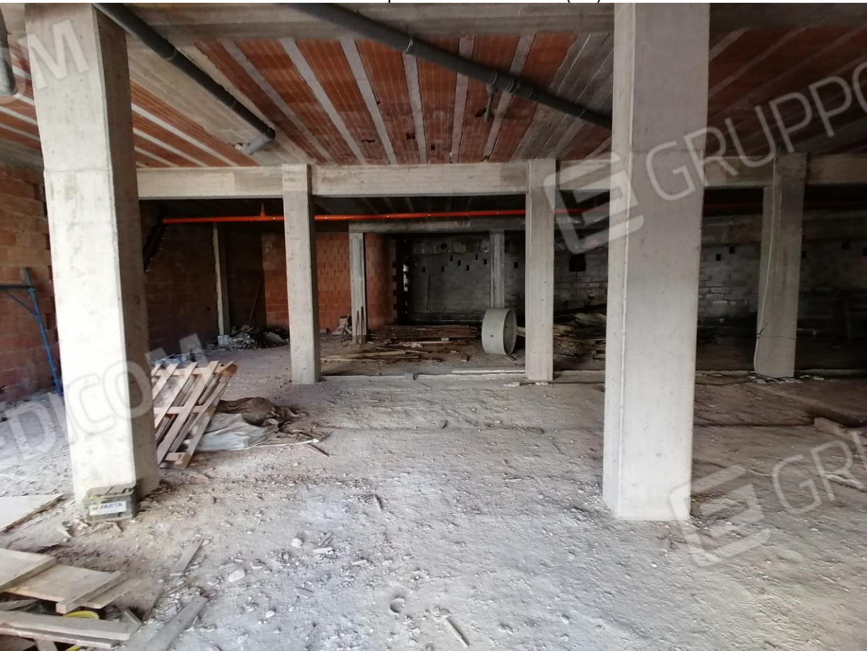
FOTO N°41: Corpo H – Locale 1 – PT (1/2).
