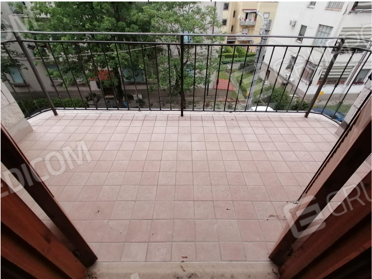
FOTO N°15: Corpo B – Balcone esposto a nord – P2.
