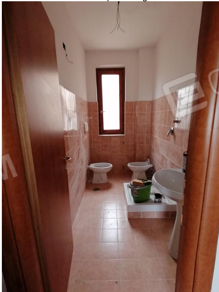
FOTO N°13: Corpo B – Bagno – P2.
