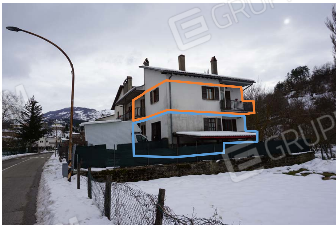
Foto n. 4 Esterno del Fabbricato Prospetto Nord - Est Lotto 001 - 002 - 003 - 004
