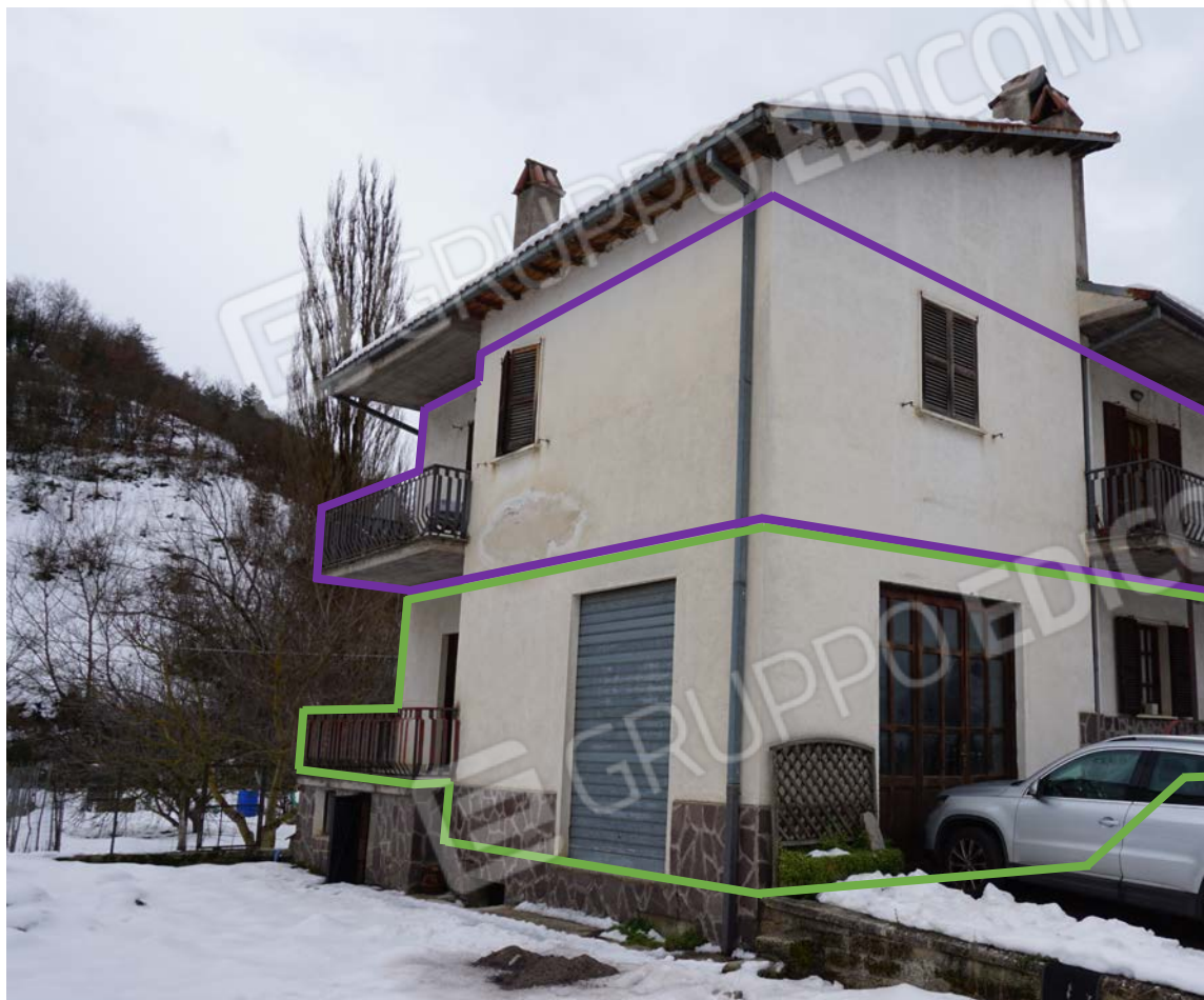
Foto n. 3 Esterno del Fabbricato Prospetto Nord- Ovest Lotto 001 - 002 - 003 - 004
