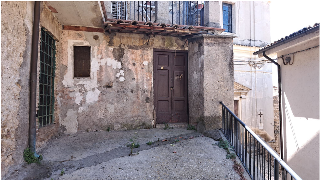
Vedute esterne del fabbricato
