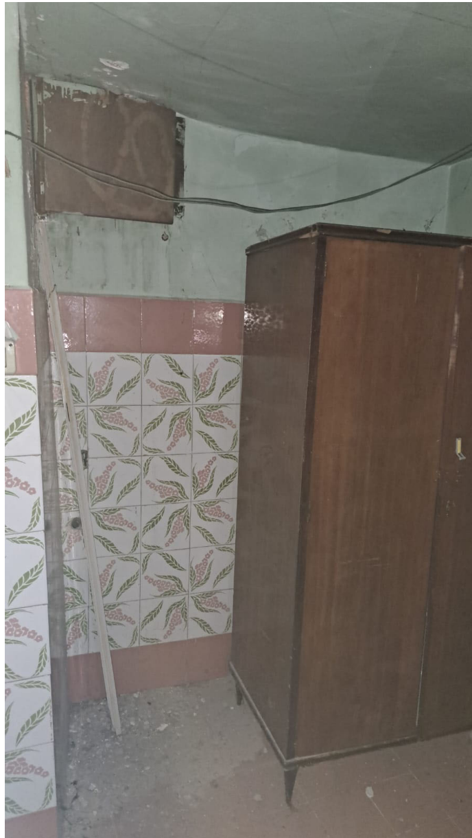
Vedute interne – disimpegno che conduce al bagno
