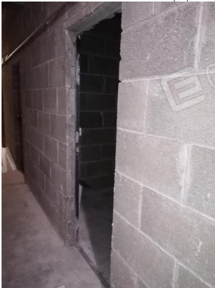
FOTO N°12: Vista esterna della cantina (2/2).
