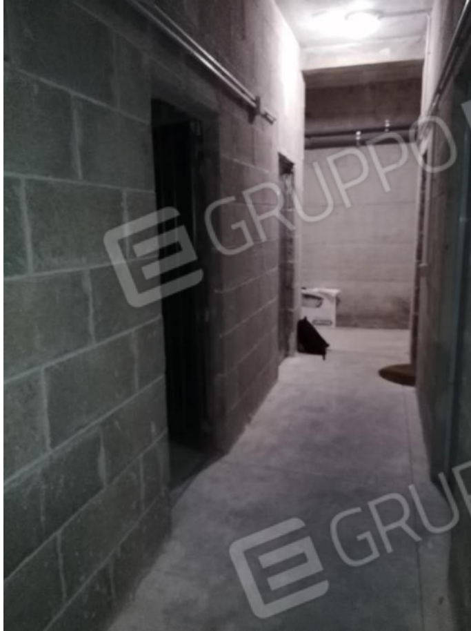
FOTO N°11: Vista esterna della cantina (1/2).
