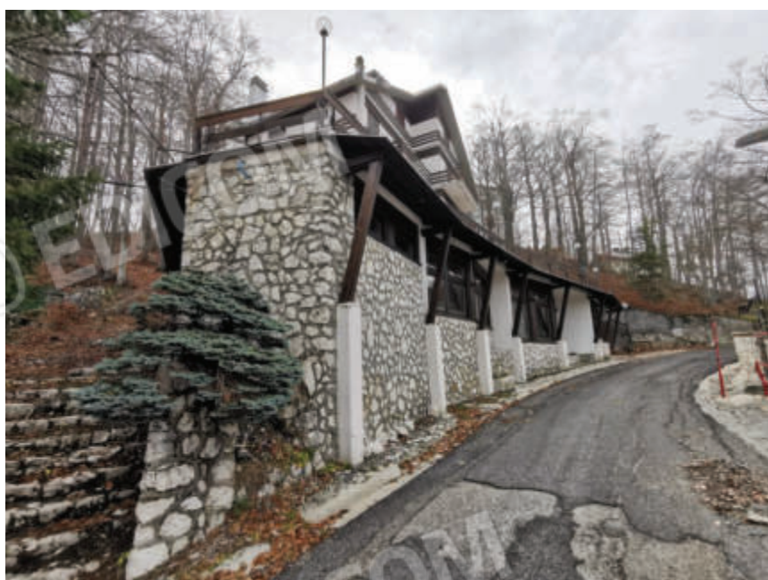
Foto 5 – Prospetto lato nord
