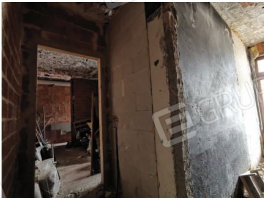
Foto 9 – Piano terra, Vista interna
