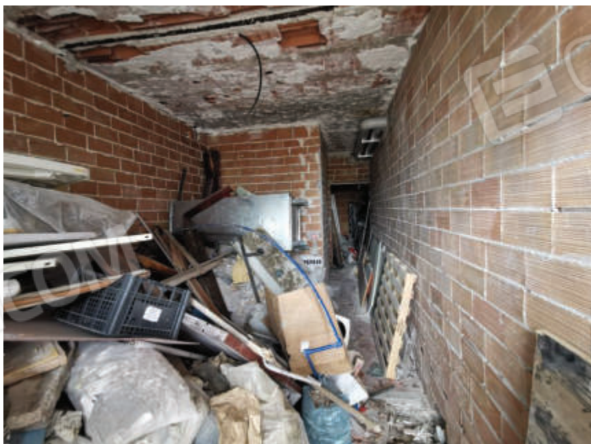
Foto 7 – Piano terra, Vista interna
