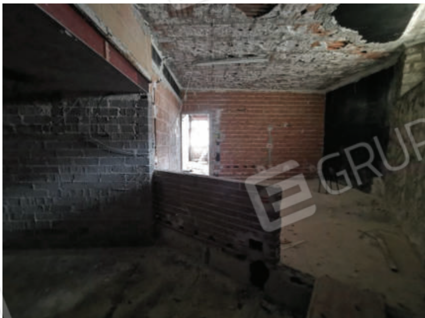
Foto 27 – Piano terra, Vista interna
