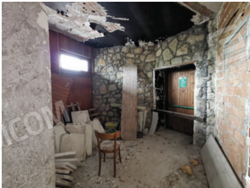
Foto 24– Piano terra, Vista interna
