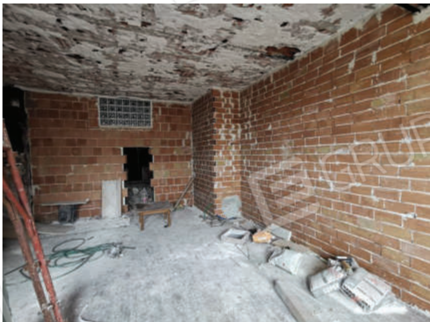
Foto 21 – Piano terra, Vista interna
