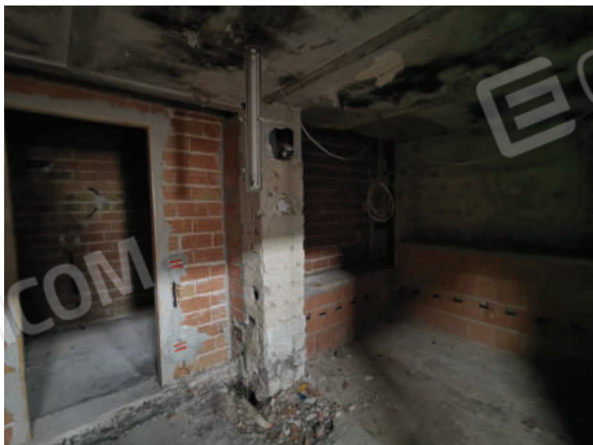
Foto 19 – Piano terra, Vista interna
