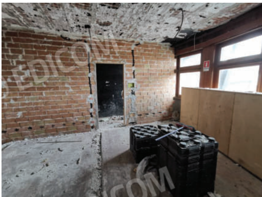
Foto 23 – Piano terra, Vista interna
