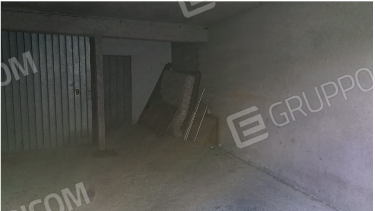
Vedute del garage al piano seminterrato – sub 19
