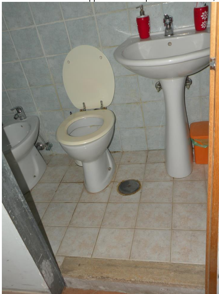
FOTO N°36: Vista interna dell'appartamento al piano seminterrato, bagno/1.
