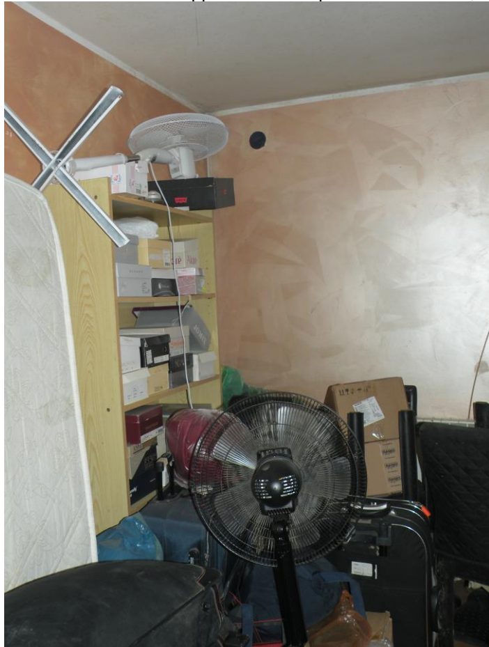
FOTO N°34: Vista interna dell'appartamento al piano seminterrato, camera/1.
