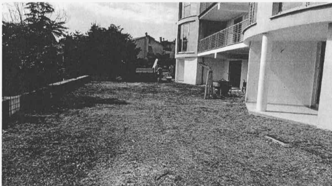
Foto 6 - area pertinenziale dopo i lavori di pulizia
