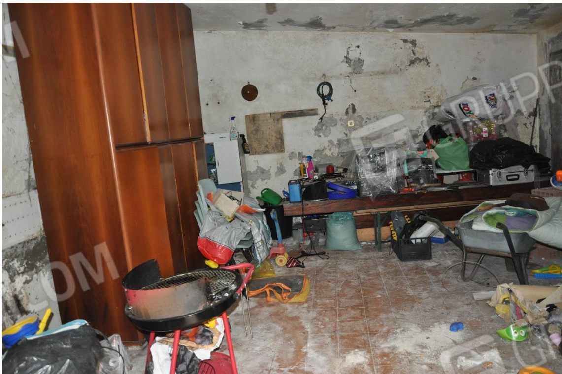
LOTTO UNICO – Fotografia n.11 - Piano Terra dell'Accessorio – L'Ambiente Garage.
