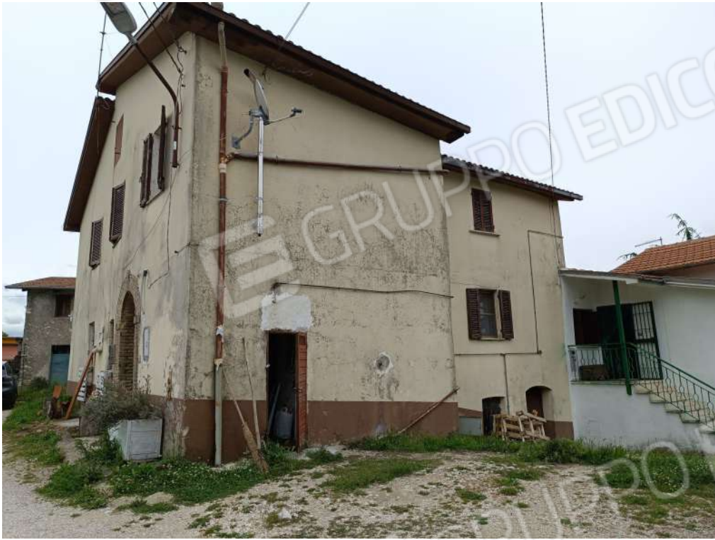
Foto n. 2 – Prospetto sud del fabbricato
