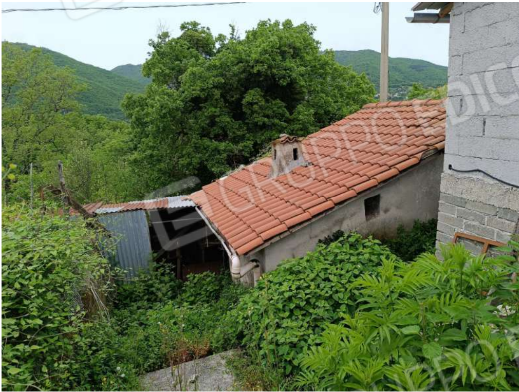
Foto n. 18 - Foglio 133 p.lla 536 - Magazzino
