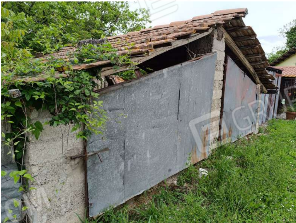
Foto n. 19 - Foglio 133 p.lla 566 - Rimessa
