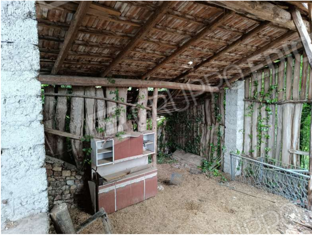
Foto n. 7 - Foglio 133 p.lla 566 - Rimessa
