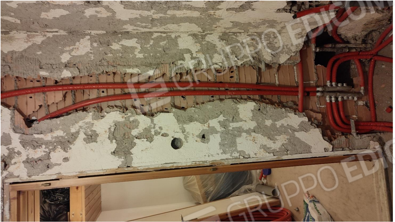
7) Particolare lavori in corso
