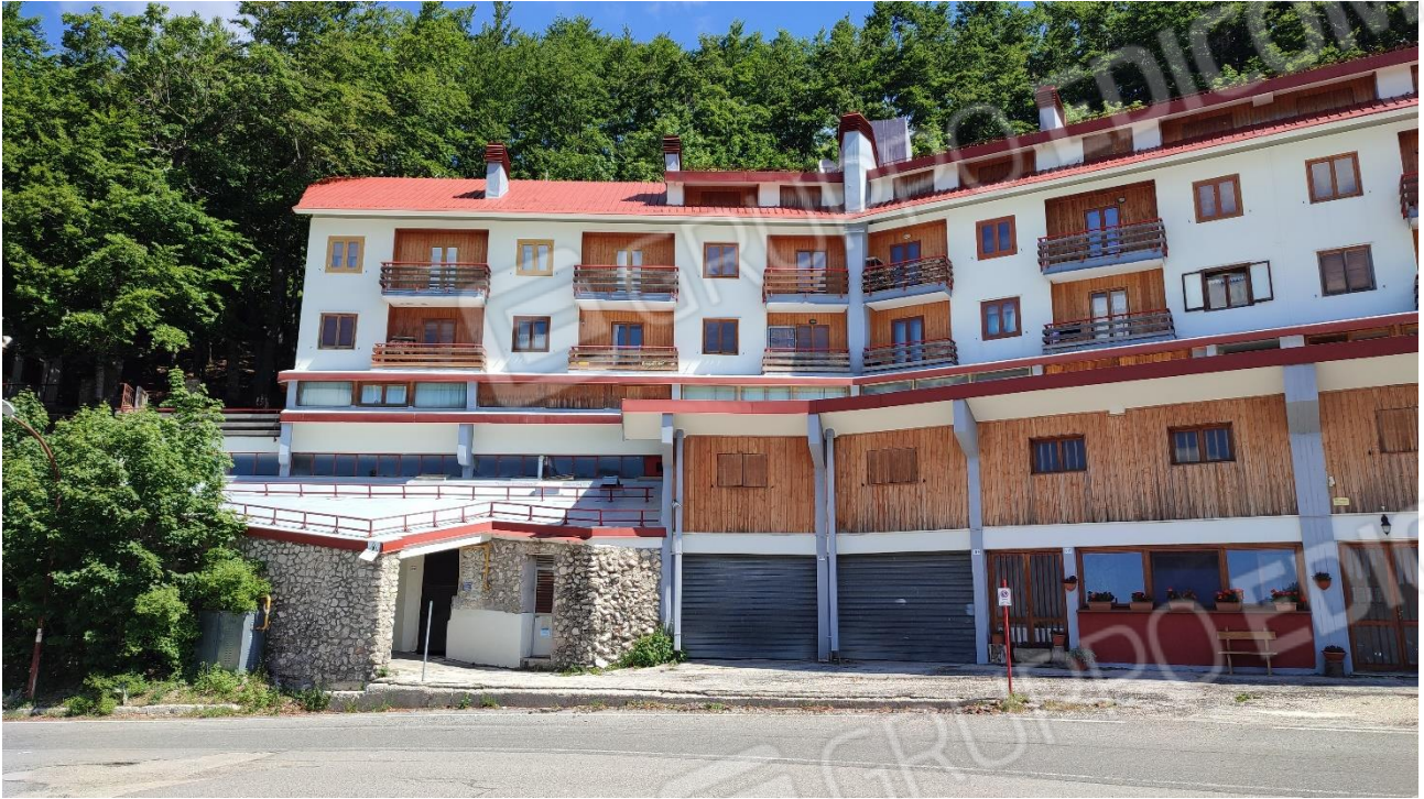
1) Vista residence da SS 4 bis
