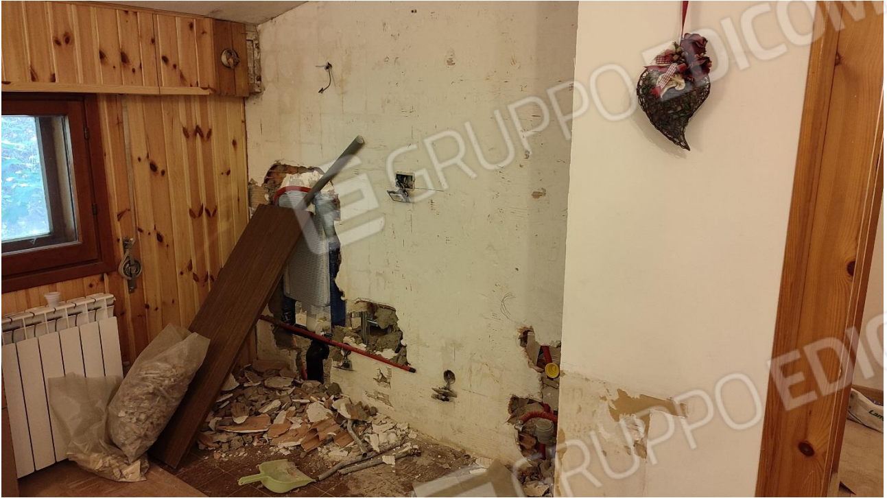
3) Angolo cucina (sono in corso lavori impiantistica)
