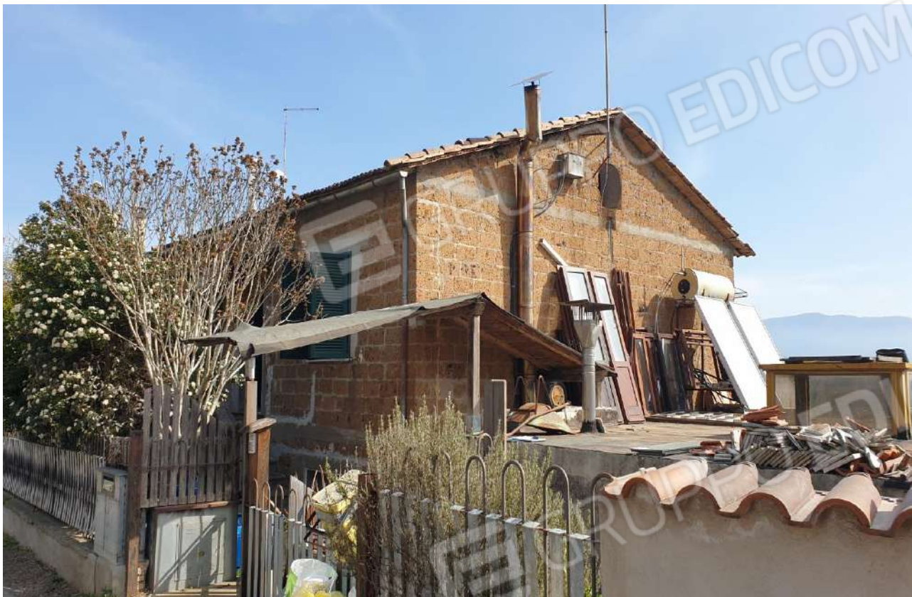
FOTO 1: Veduta esterna prospetto anteriore da via del Balcone
