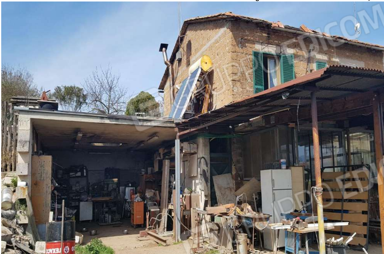
FOTO 5: Veduta esterna prospetto posteriore da part. 202
