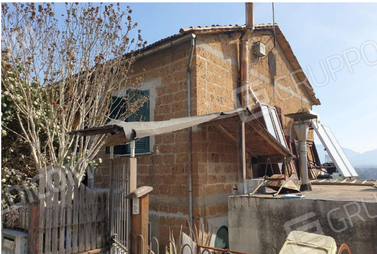
FOTO 6: Veduta esterna prospetto anteriore da via del Balcone
