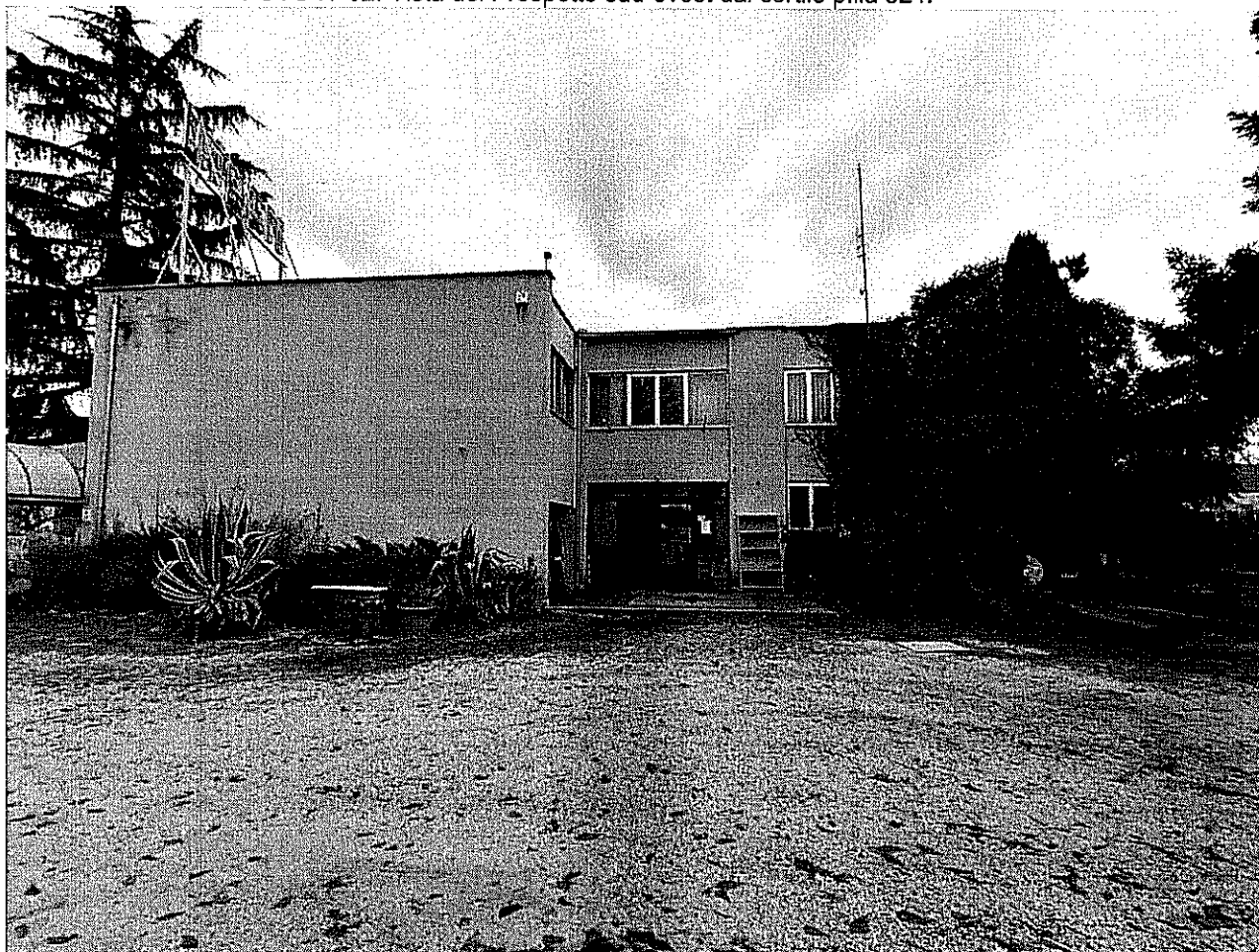
FOTO N°02: Vista del Prospetto sud-ovest dal cortile p.lla 324.
