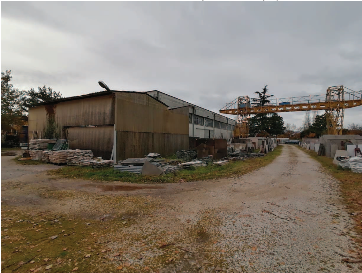
FOTO N°08: Vista delle tettoie esposte a nord-est (2/2).
