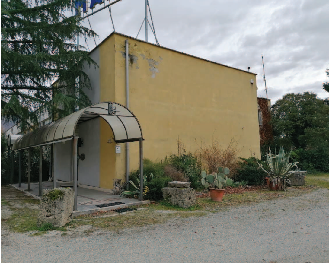
FOTO N°03: Vista del Prospetto nord-ovest dal cortile p.lla 324.
