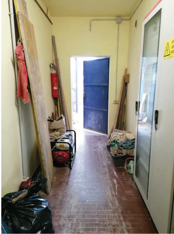
FOTO N°11: Vista interna del corridoio al PT (2/2).
