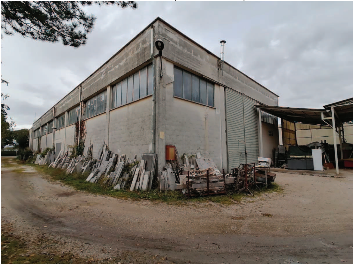
FOTO N°06: Vista del Prospetto est dal cortile p.lla 324.
