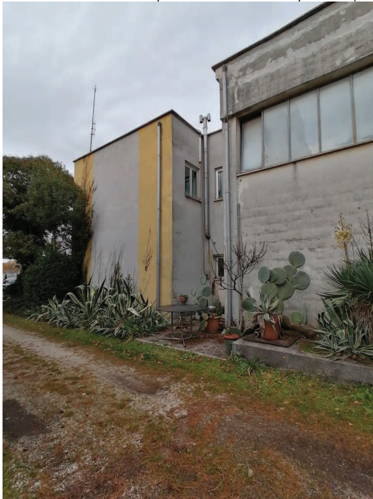
FOTO N°04: Vista del Prospetto sud-est dal cortile p.lla 324 (1/2).
