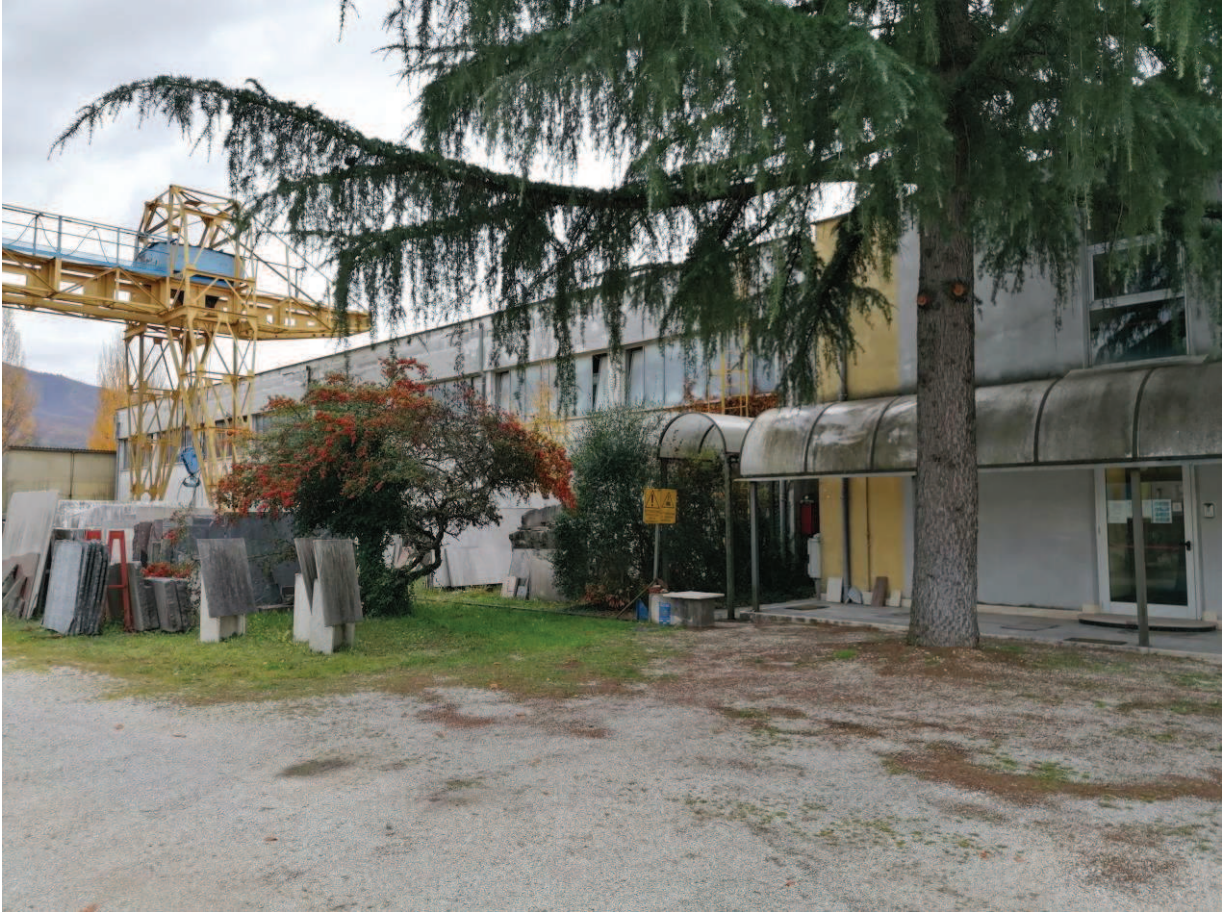
FOTO N°09: Vista del Prospetto nord dal cortile p.lla 324.
