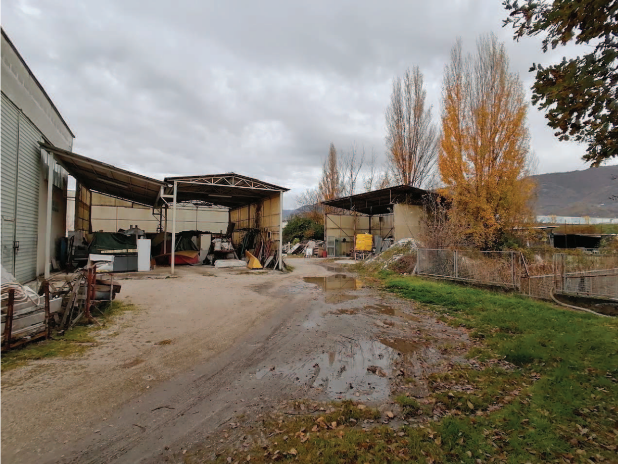
FOTO N°07: Vista delle tettoie esposte a nord-est (1/2).
