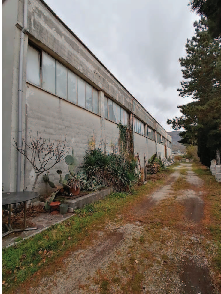
FOTO N°05: Vista del Prospetto sud-est dal cortile p.lla 324 (2/2).
