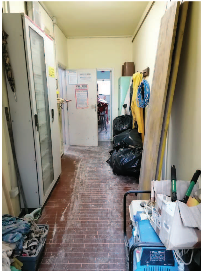
FOTO N°10: Vista interna del corridoio al PT (1/2).
