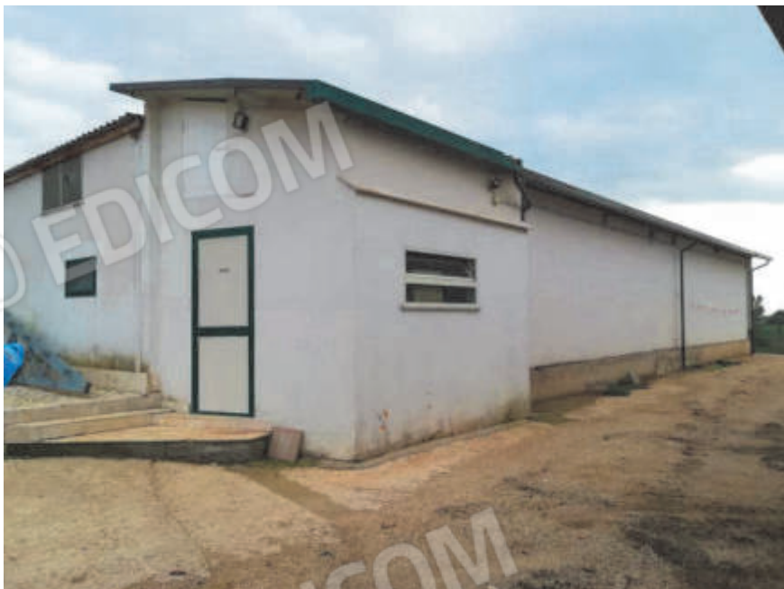
Foto 5 – Vista esterna – Prospetto nord
