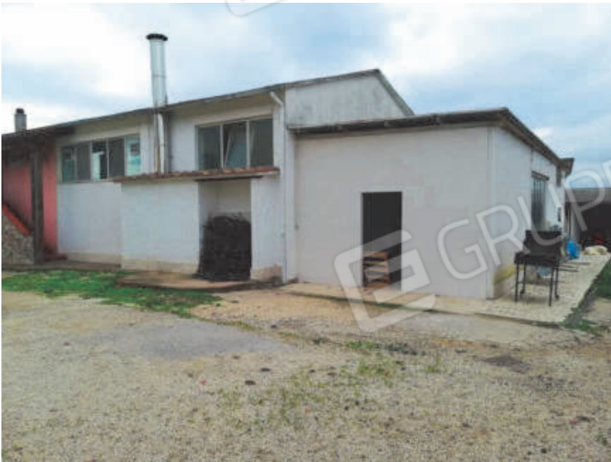
Foto 3 – Vista esterna – Prospetto sud
