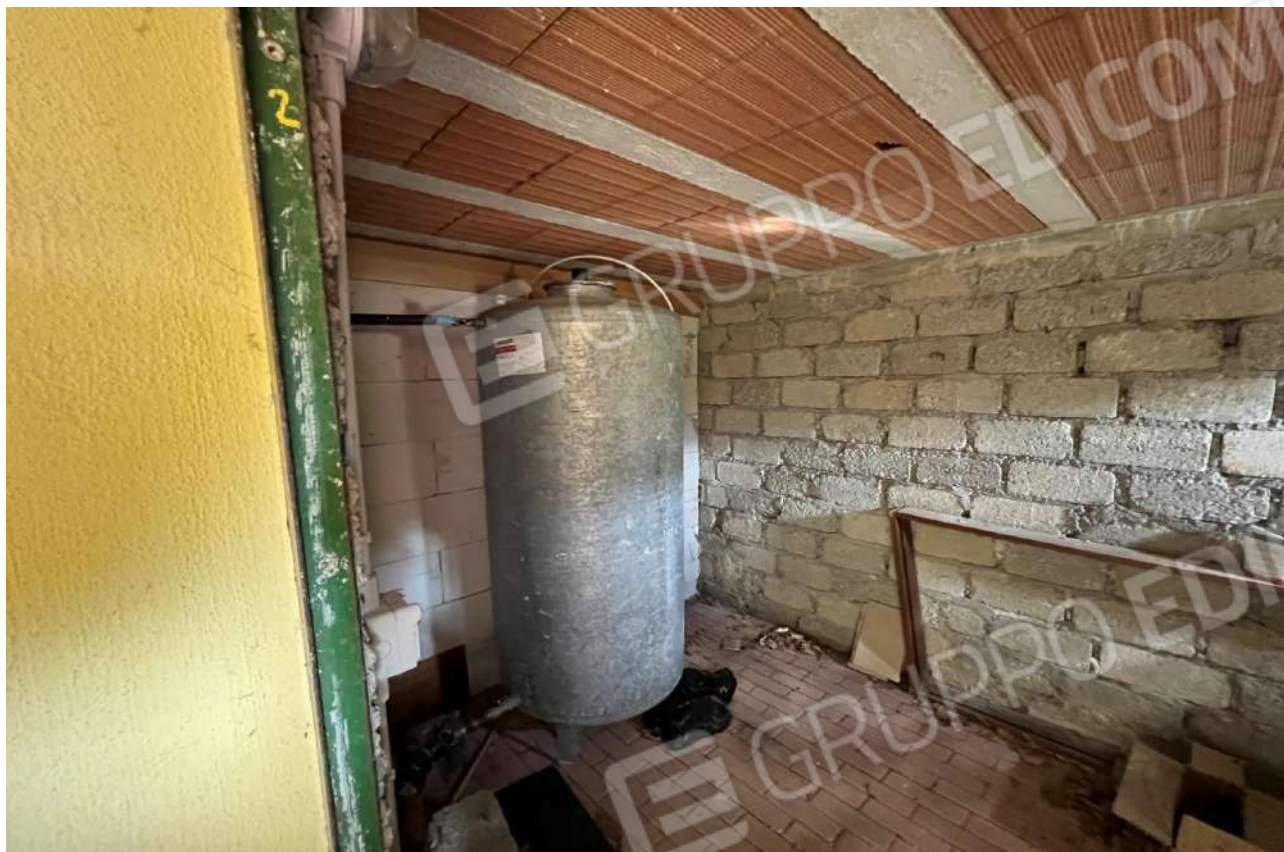
FOTO 13: Veduta interna vano cantina di pertinenza Lotto 3, Corpo A-piano terra
