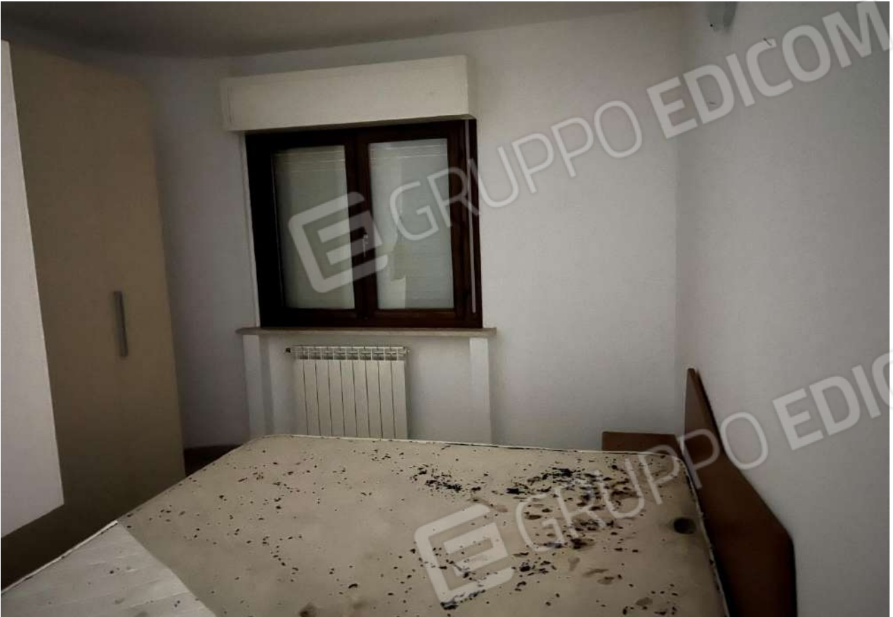
FOTO 17: Veduta interna vano camera da letto Lotto 2, Corpo A-piano terra
