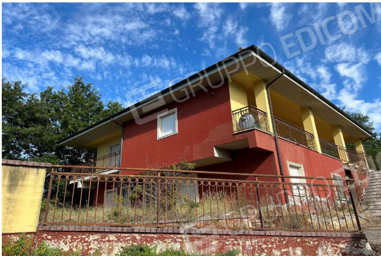
FOTO 1: Veduta esterna lato sud-est
