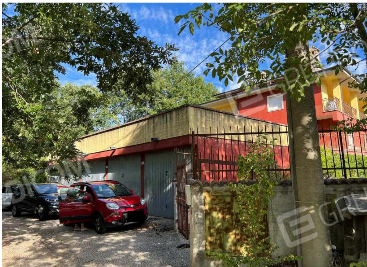
FOTO 6: Veduta esterna garage interrati su via Defensa
