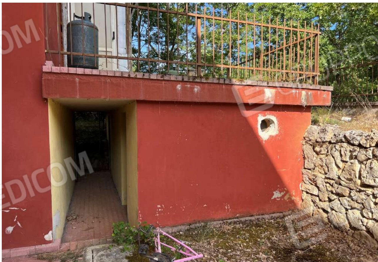
FOTO 14: Veduta esterna vano cantina di pertinenza Lotto 3, Corpo A-piano terra
