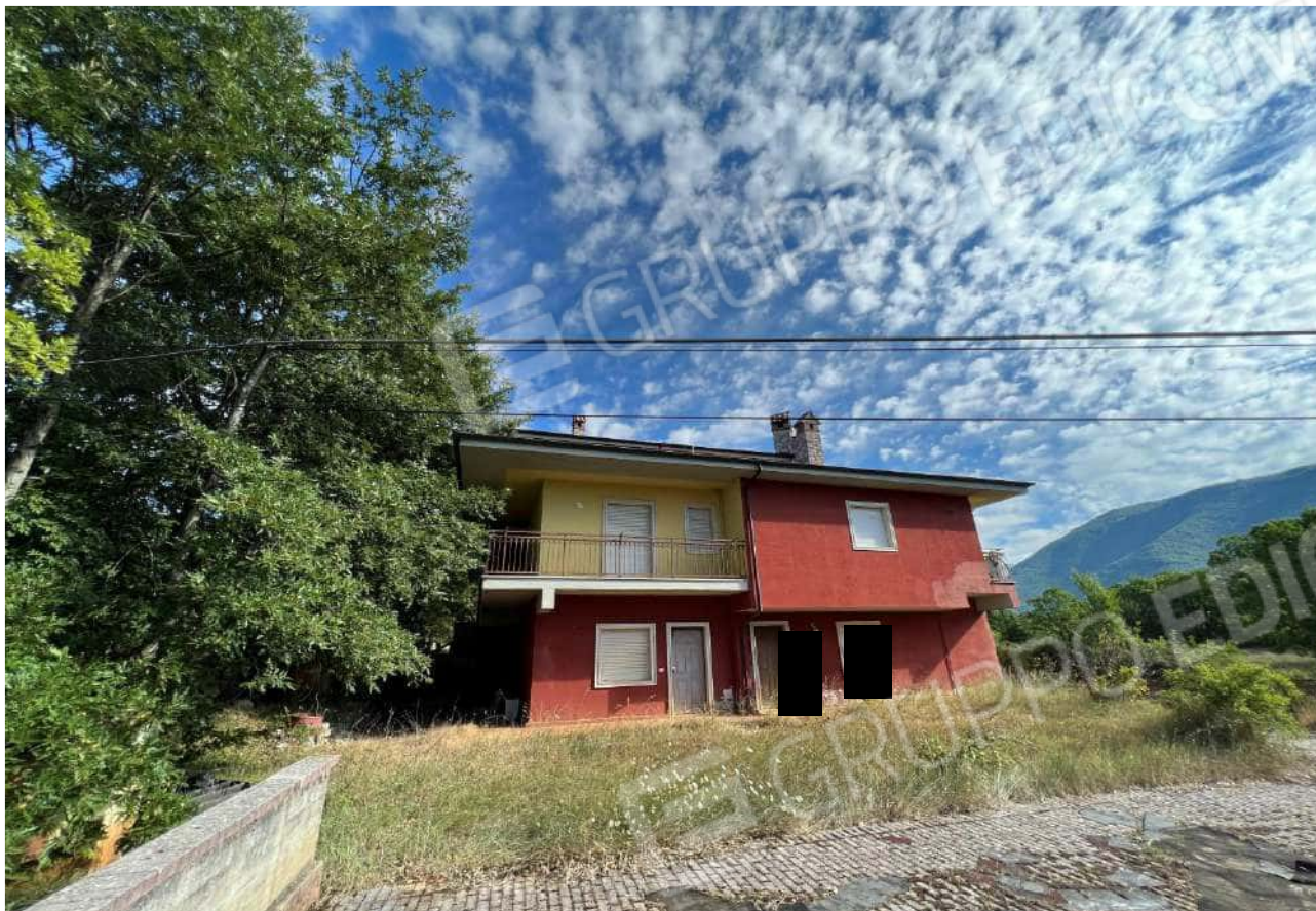
FOTO 3: Veduta esterna lato sud-ovest
