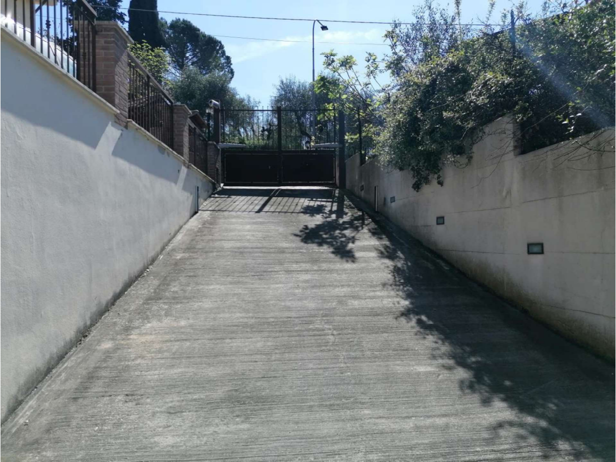
FOTO N°03: Rampa di accesso ai garage al piano seminterrato.
