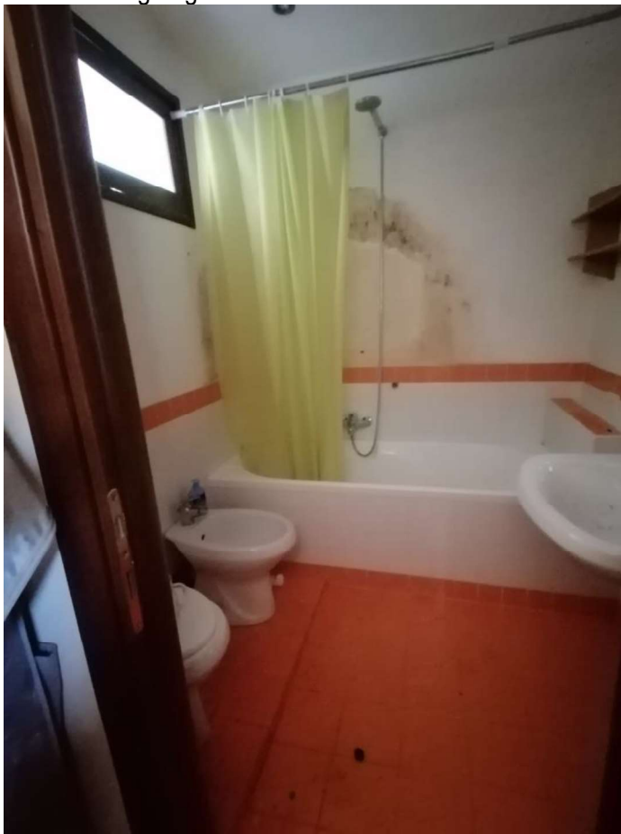
FOTO N°23: Vista interna del garage adibito a monolocale al Piano Seminterrato, bagno (2/2).
