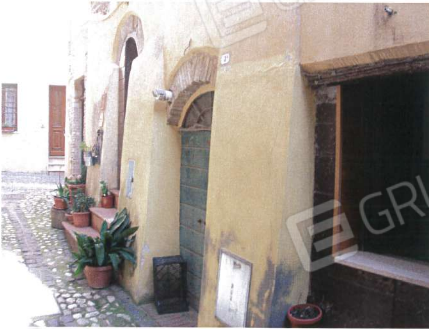
Vedute esterne del fabbricato
