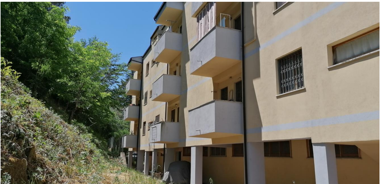
2) Prospetto posteriore del fabbricato
