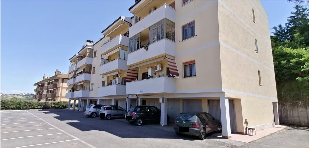
1) Vista prospetto principale del fabbricato. L'abitazione è sita a secondo piano lato destro con balcone finestrato
