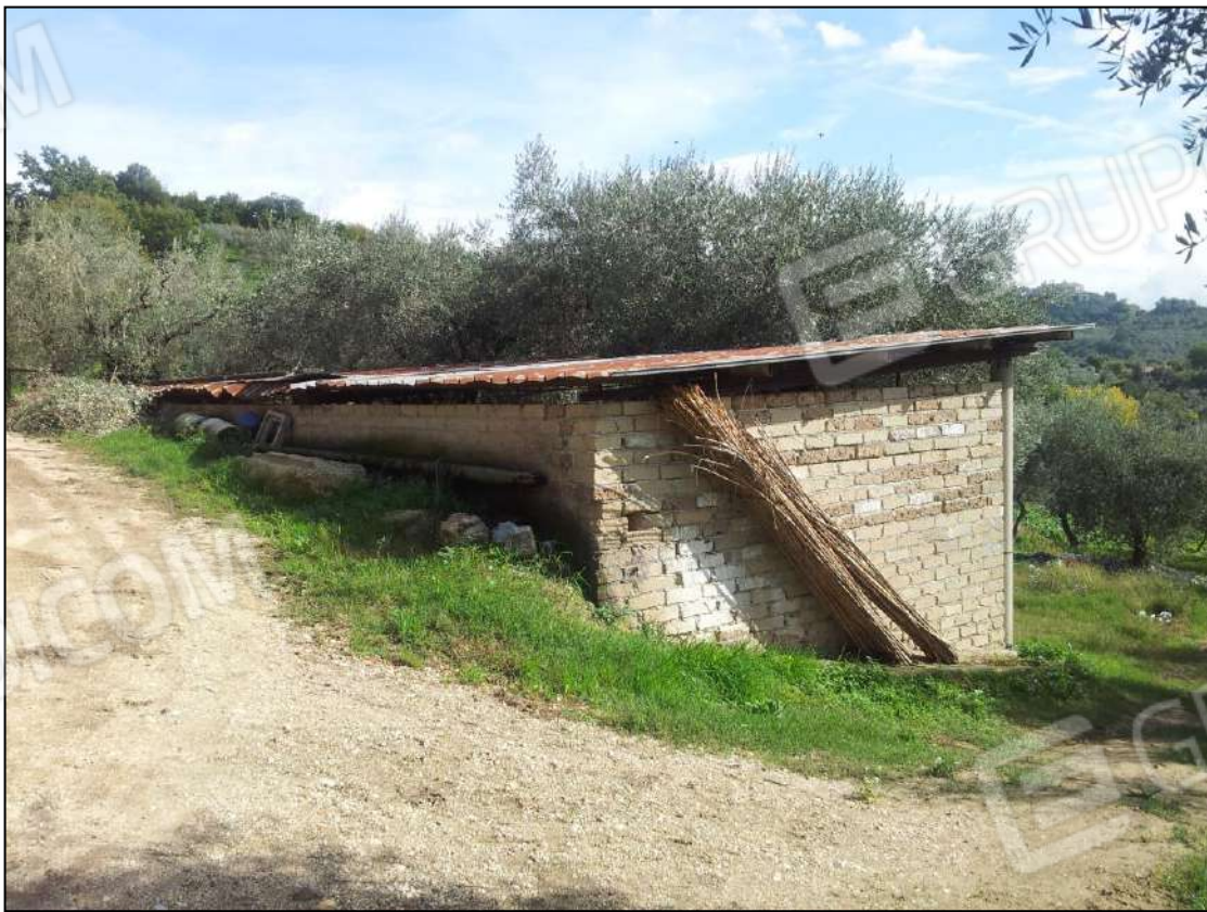
Foto 24 – Vista tettoia seminterrata realizzata sulla p.lla 265
