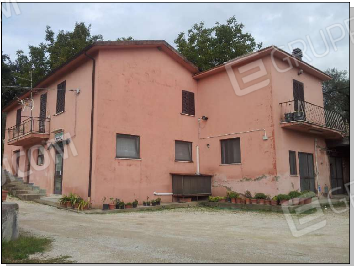
Foto 4 – Vista esterna – lati nord
