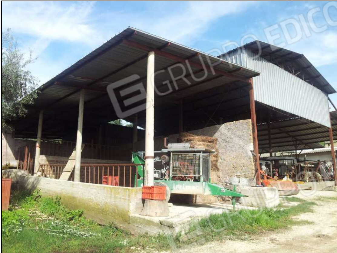
Foto 19 – Vista Tettoia rimessa attrezzi – lato sud
