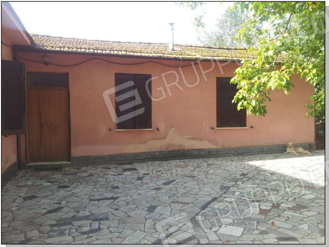
Foto 3 – Vista esterna lato sud-ovest
