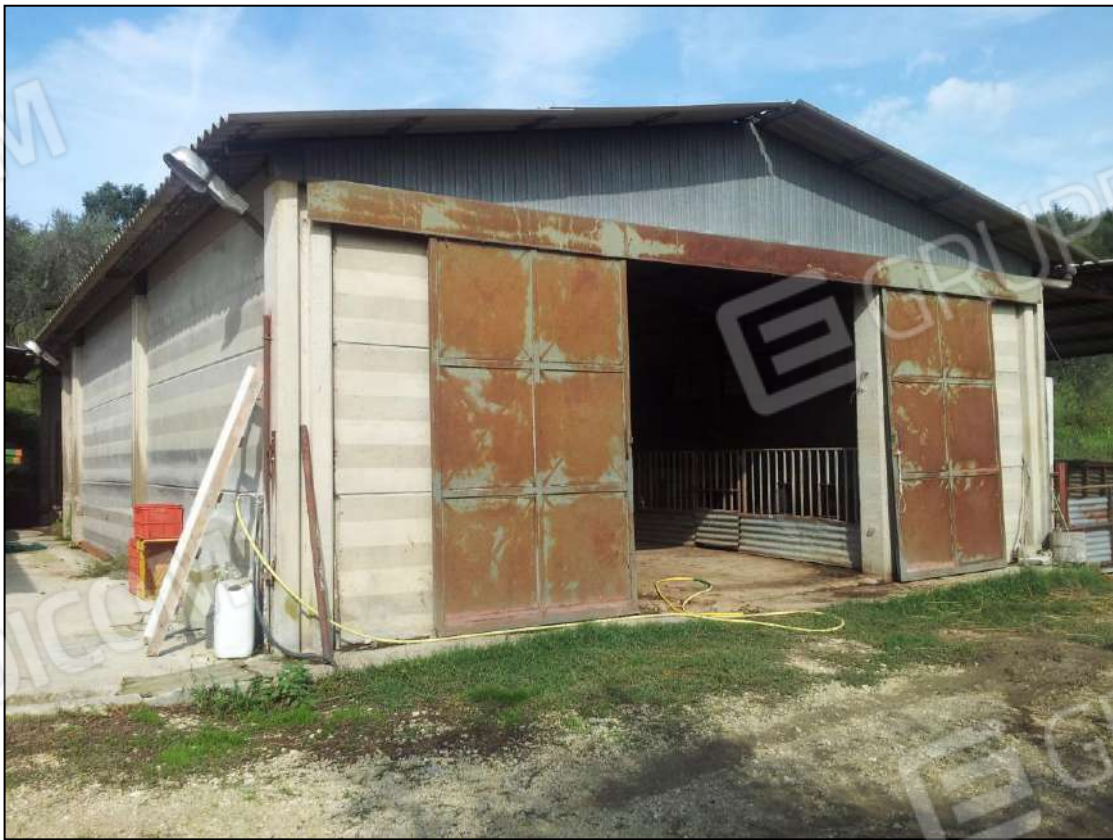
Foto 22 – Vista Capannone ricovero animali – lato sud-est
