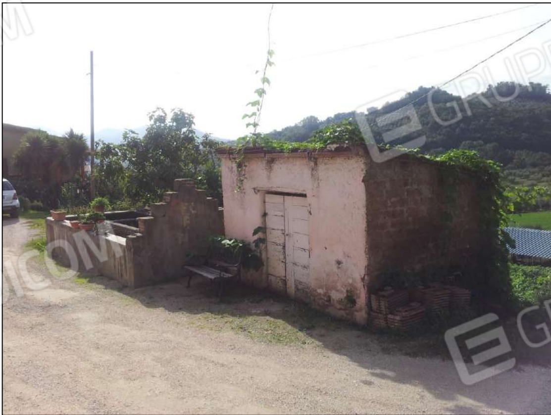
Foto 6 – Vista esterna ripostiglio e fontanile
