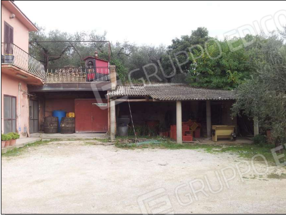
Foto 5 – Vista esterna tettoie annesse – sub.5
