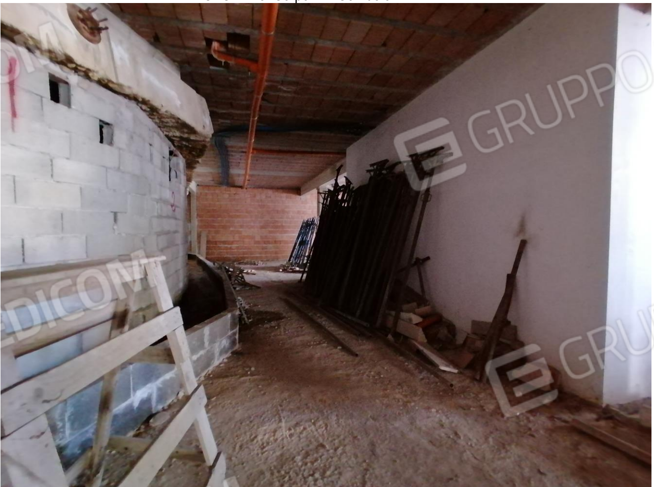
FOTO N°43: Corpo H – Corridoio – PT.
