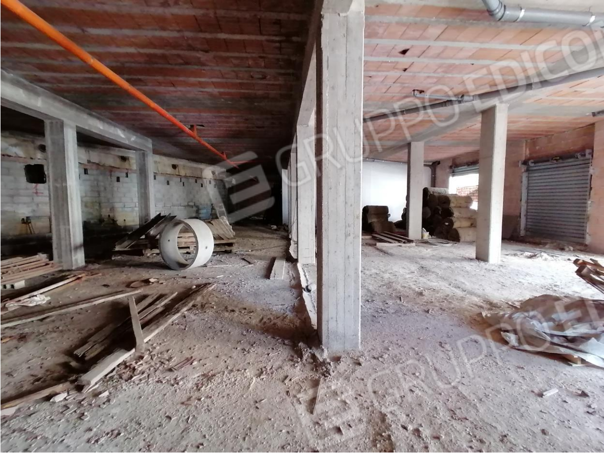
FOTO N°42: Corpo H – Locale 1 – PT (2/2).
