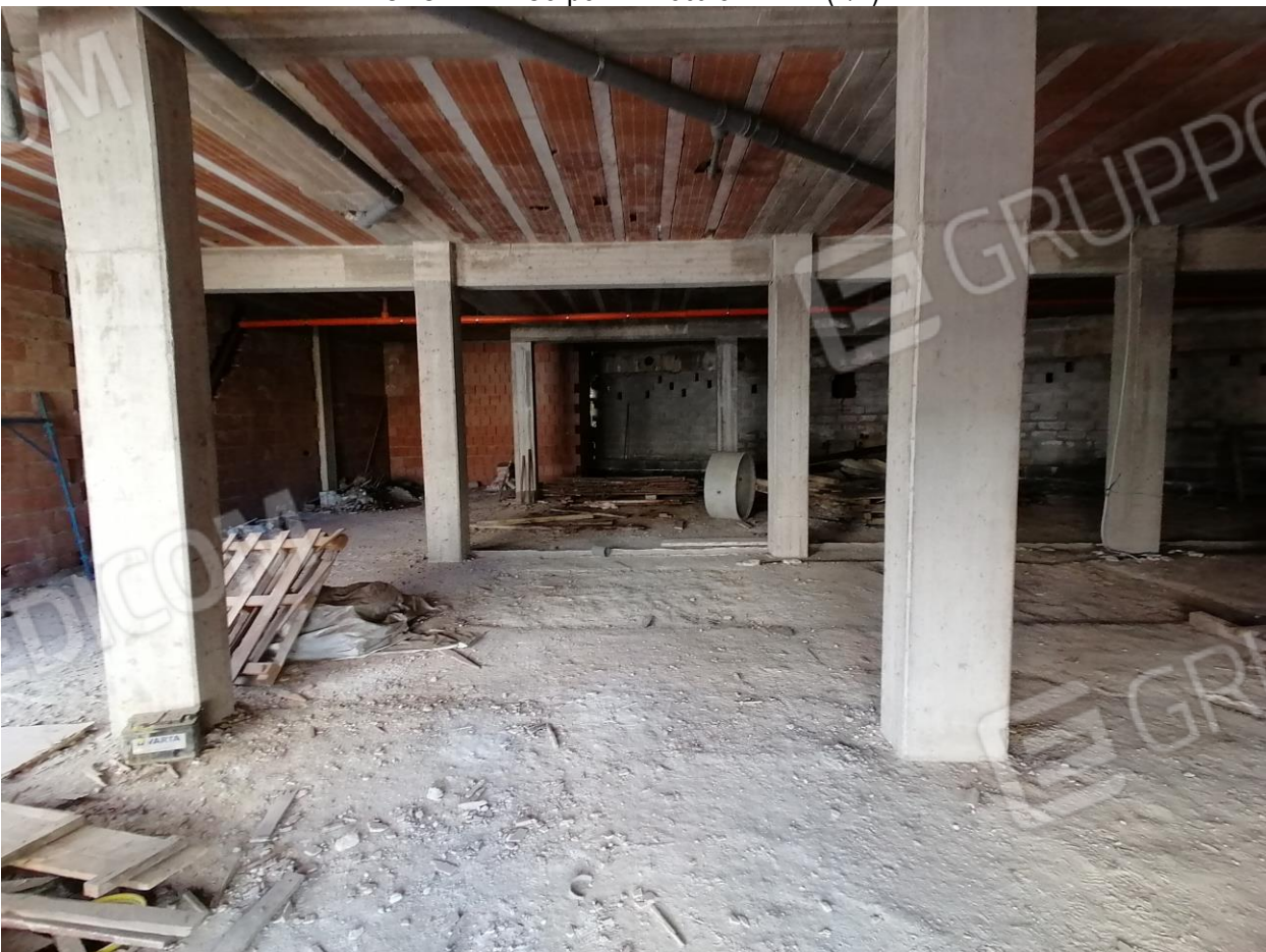
FOTO N°41: Corpo H – Locale 1 – PT (1/2).
