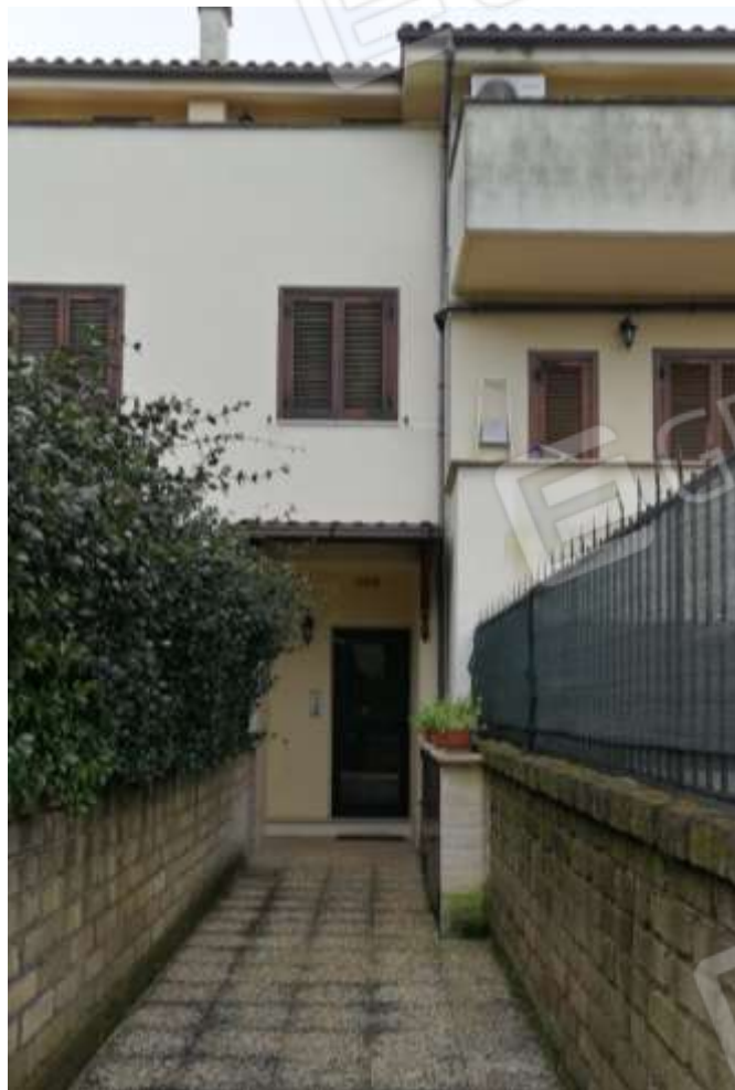
FOTO 02 – Vista Esterna (ingresso condominiale)
