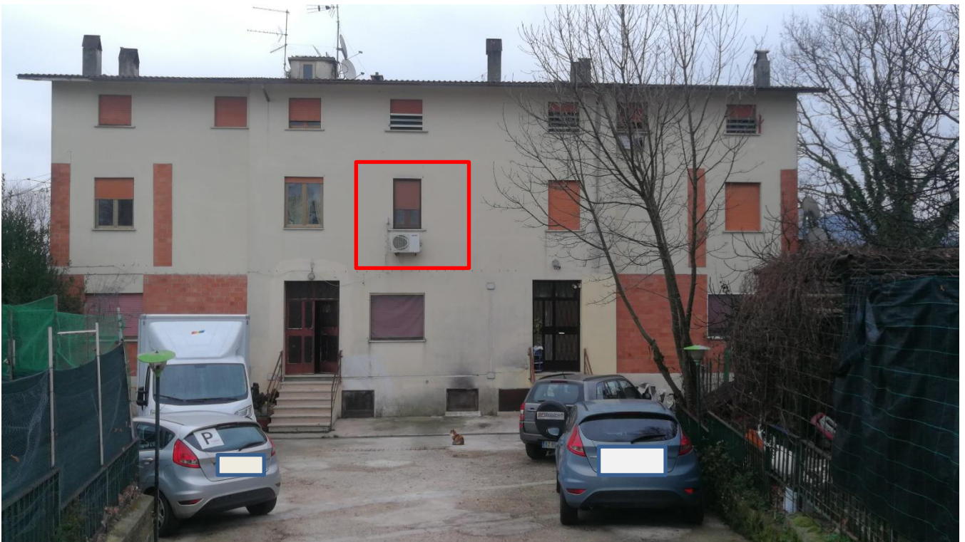
FOTO 04 – Vista esterna (prospetto Ovest)
