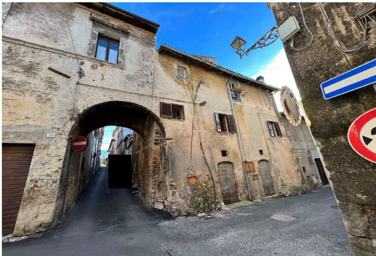
FOTO 2: Veduta esterna lato strada pubblica via Duca Roberto
