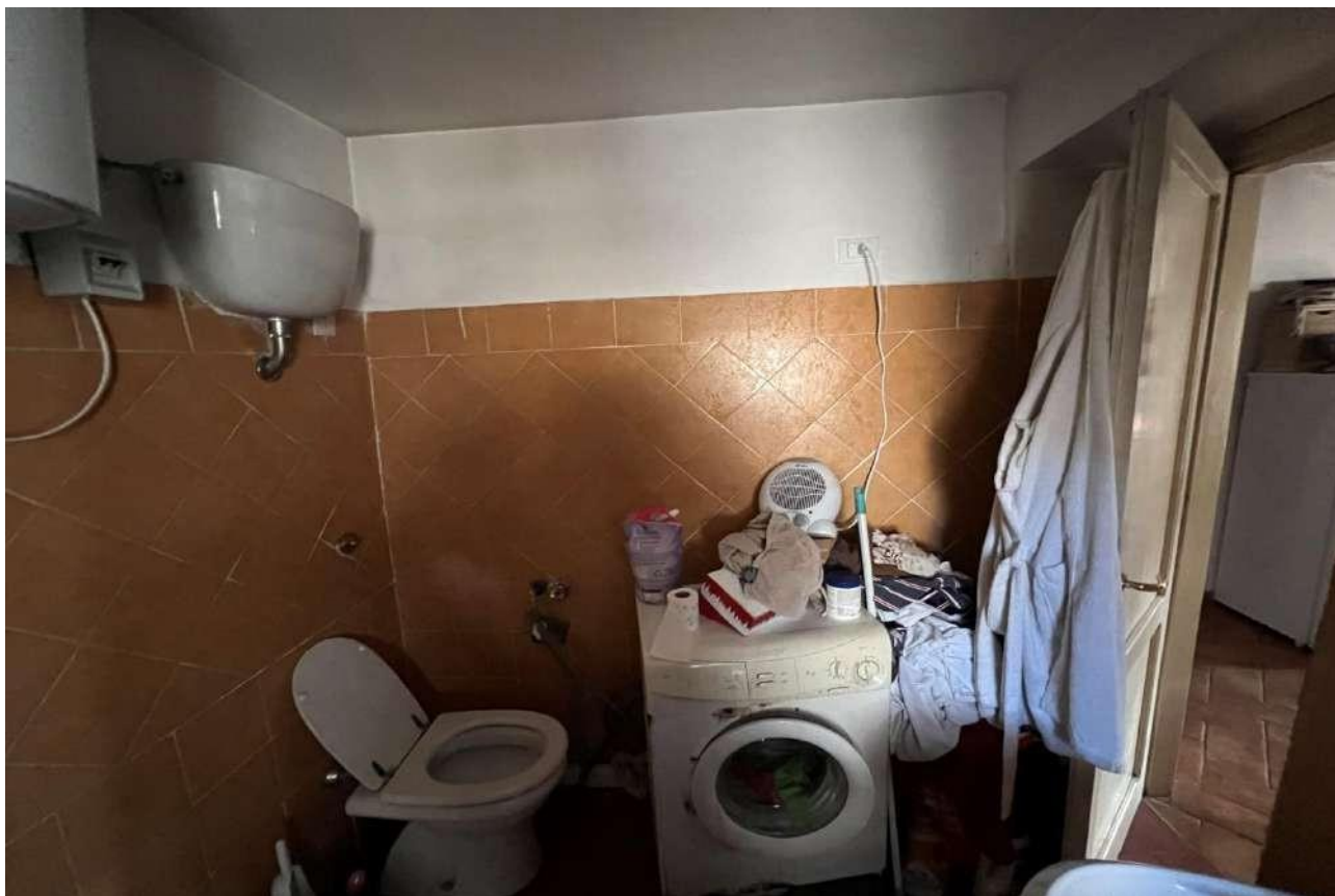
FOTO 7: Veduta interna vano bagno piano secondo
