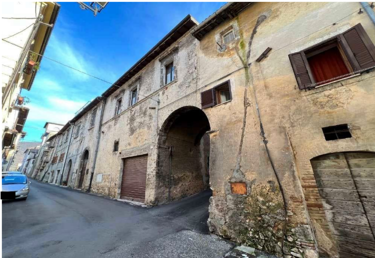
FOTO 1: Veduta esterna lato strada pubblica via Duca Roberto
