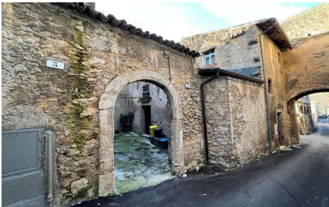
FOTO 3: Veduta esterna lato strada pubblica via Leoni
