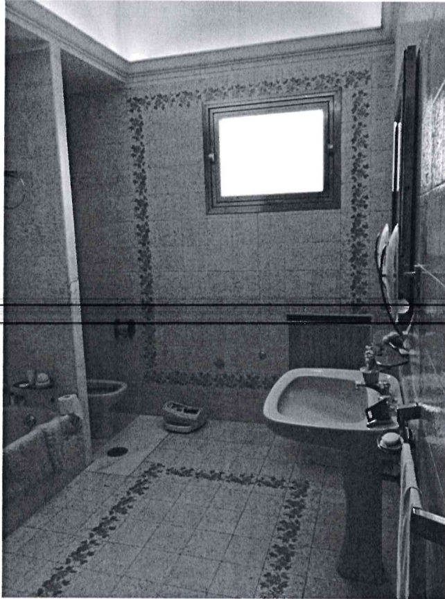
foto n°27 - bagno zona notte
