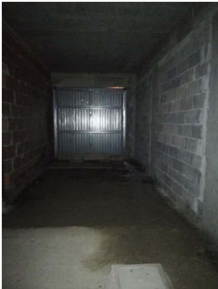
Foto 29 e 30 - Vista interna garage, piano S1
