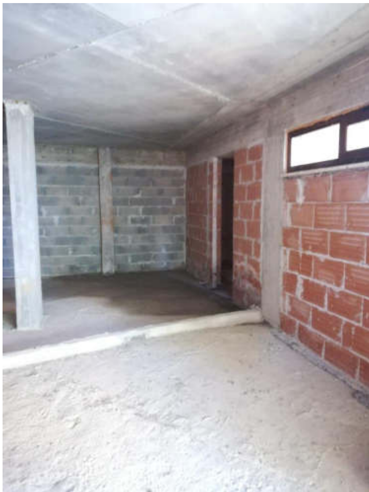
Foto 50 e 51 - Vista interna garage , piano S1
