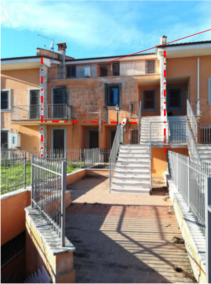
Foto 11 e 12 – Vista esterna – Prospetto Sud/est
