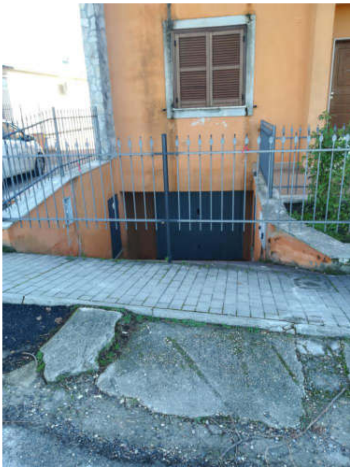
Foto 16 e 17 – Lotto n. 1 - Vista garage
