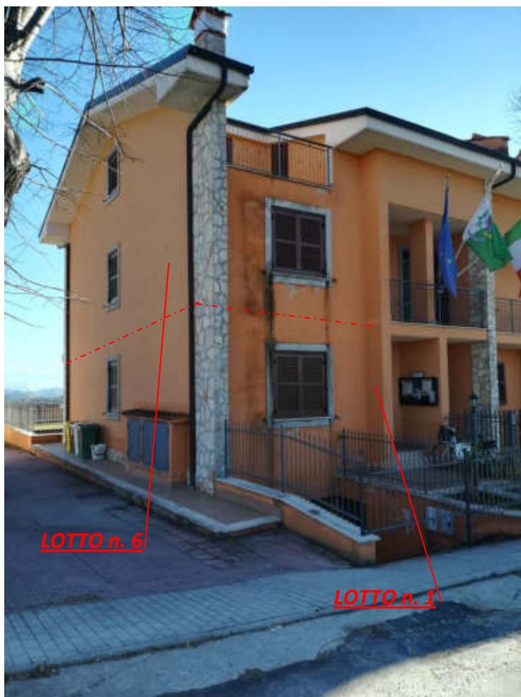
Foto 5 – Vista esterna, prospetto nord/est
