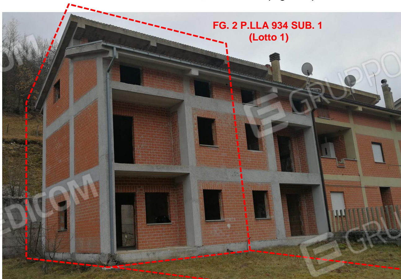
Foto 02 – Vista Esterna lato Ovest (Ingresso)
