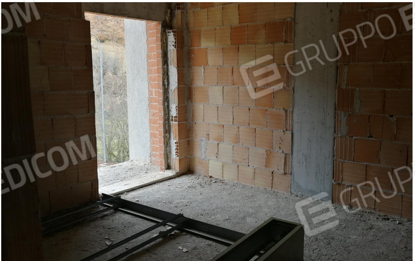
Foto 04 – Vano 05 (Piano Primo)
