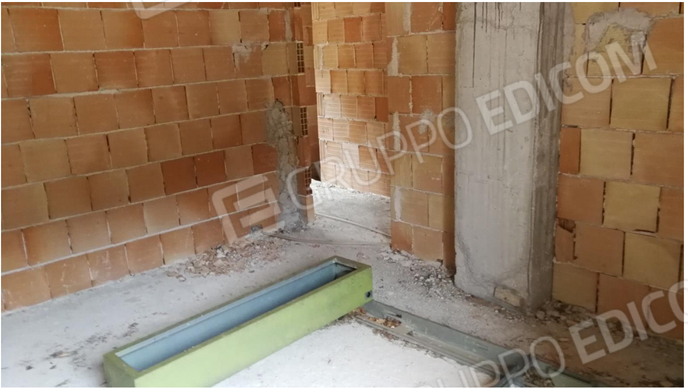
Foto 05 – Vano 05 (Piano Primo)
