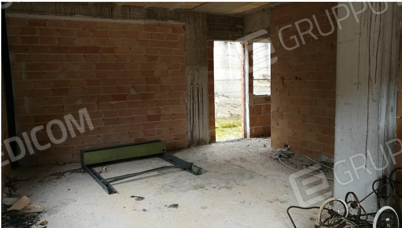
Foto 10 - Vano 01 (Piano Terra)
