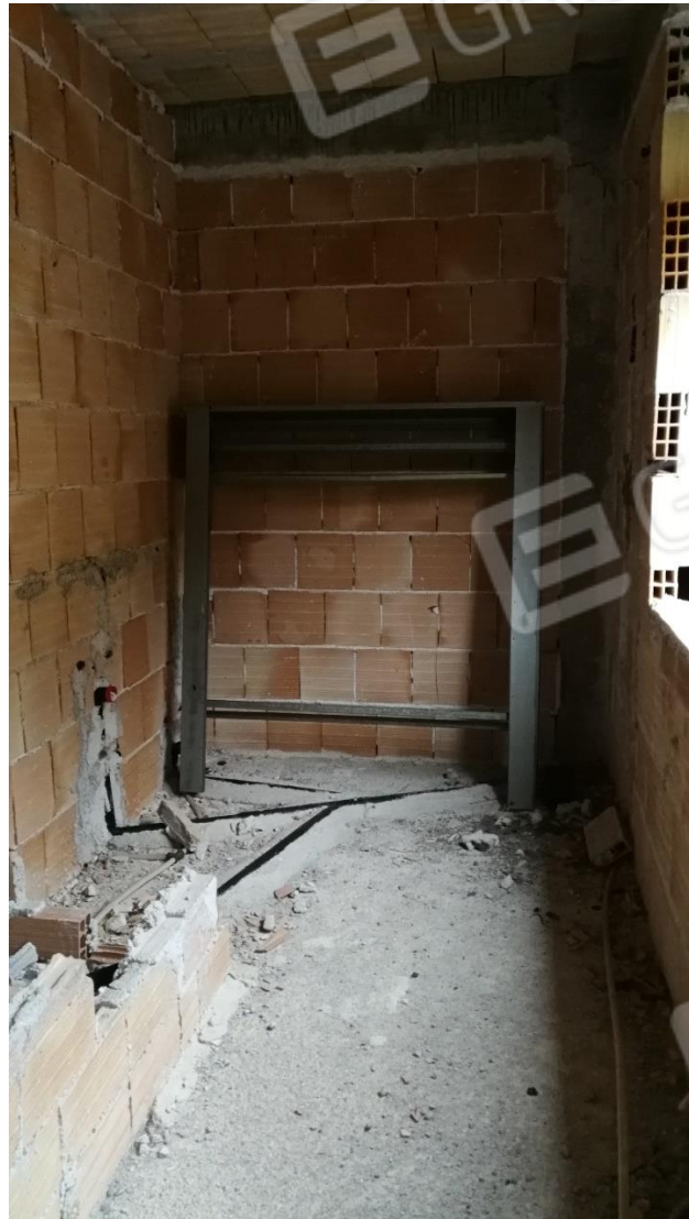
Foto 06 – Vano 04 (Piano Primo)
