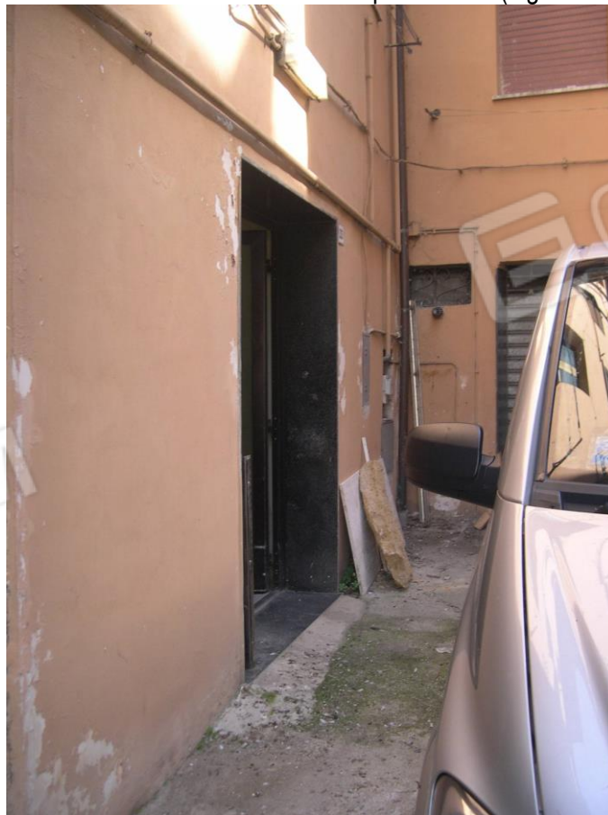
BENE 3 FOTO N°2: Prospetto Ovest (ingresso Sub 20).
