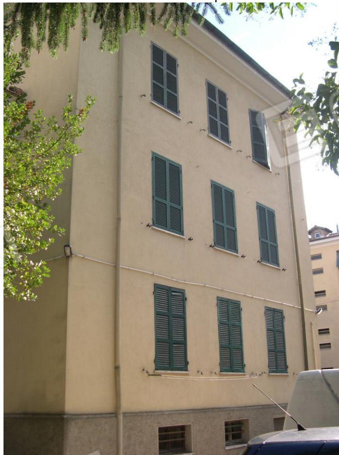
BENE 1 FOTO N°6: Prospetto Nord.
