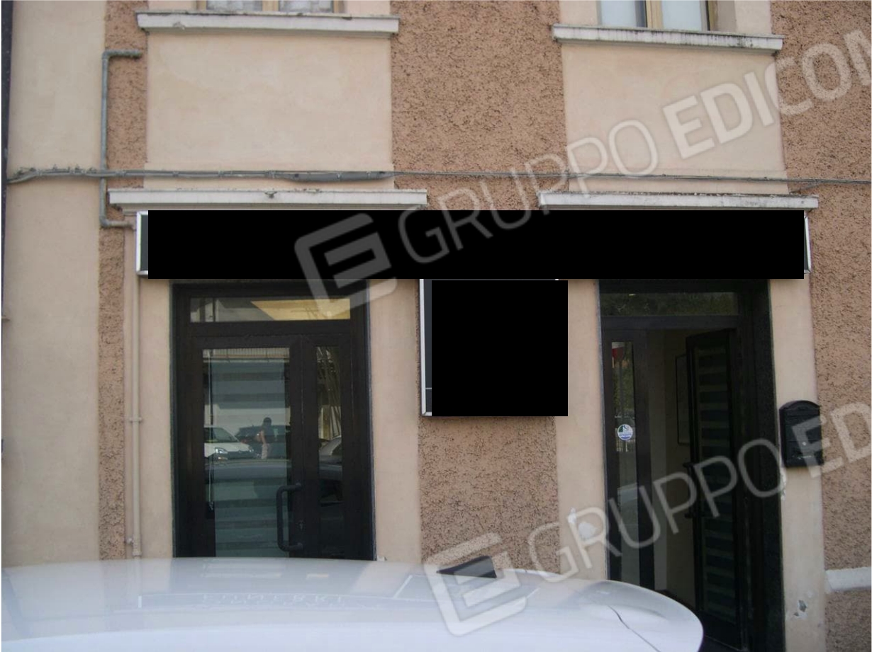
BENE 2 FOTO N°3: Prospetto Est, particolare ingresso Sub 17.
