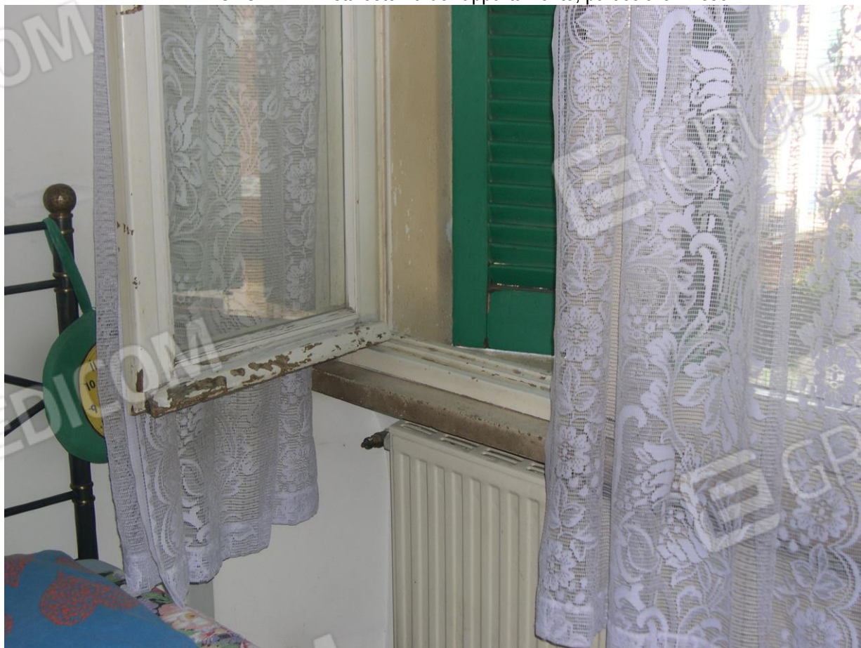
BENE 1 FOTO N°24: Vista esterna dell'appartamento, particolare infisso.
