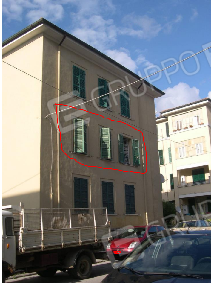
BENE 1 FOTO N°5: Prospetto Sud.
