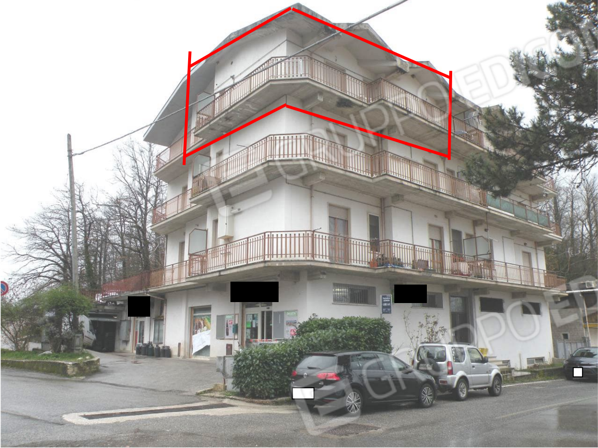
FOTO N°3: Prospetto Nord del fabbricato condominiale di cui la U.I. oggetto di pignoramento fa parte/1.
