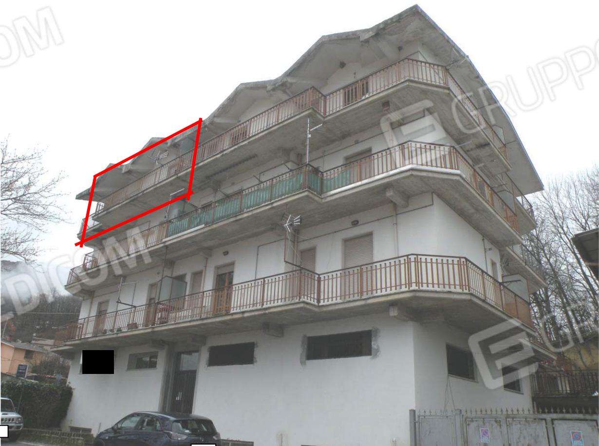
FOTO N°4: Prospetto Nord del fabbricato condominiale di cui la U.I. oggetto di pignoramento fa parte/2.
