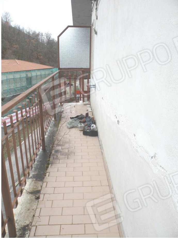
FOTO N°24: Vista esterna dell'appartamento al piano secondo, balcone/4.
