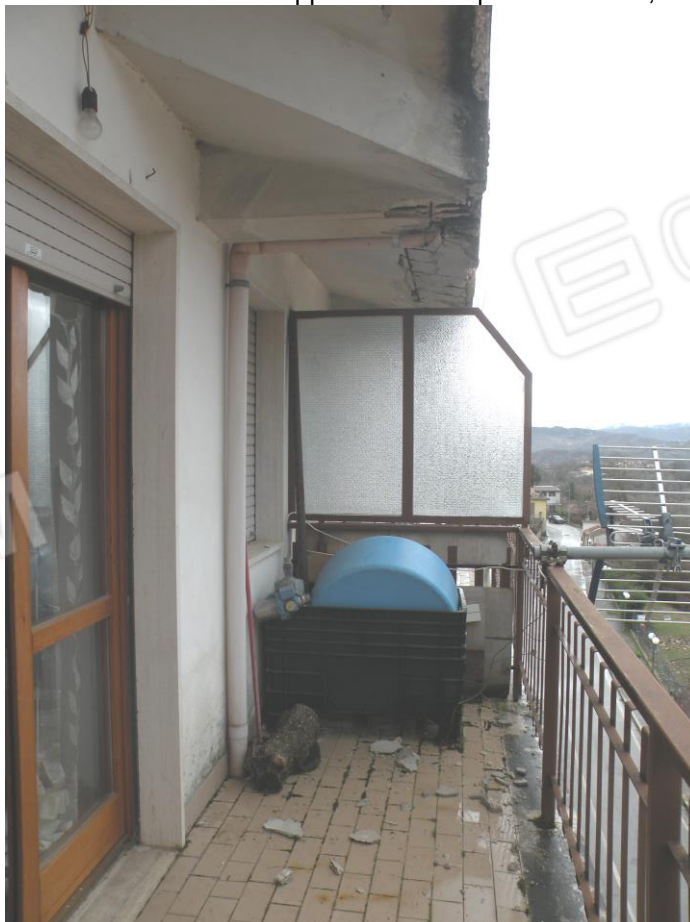
FOTO N°21: Vista esterna dell'appartamento al piano secondo, balcone/1.
