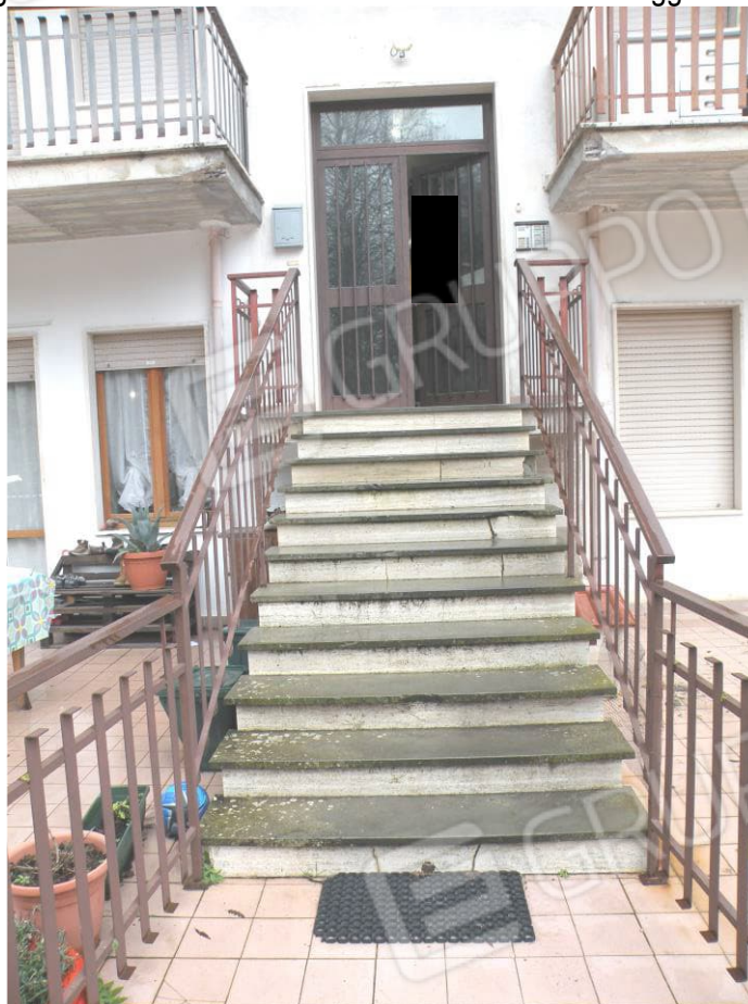
FOTO N°7: Ingresso vano scala condominiale di accesso all'U.I. oggetto di pignoramento.
