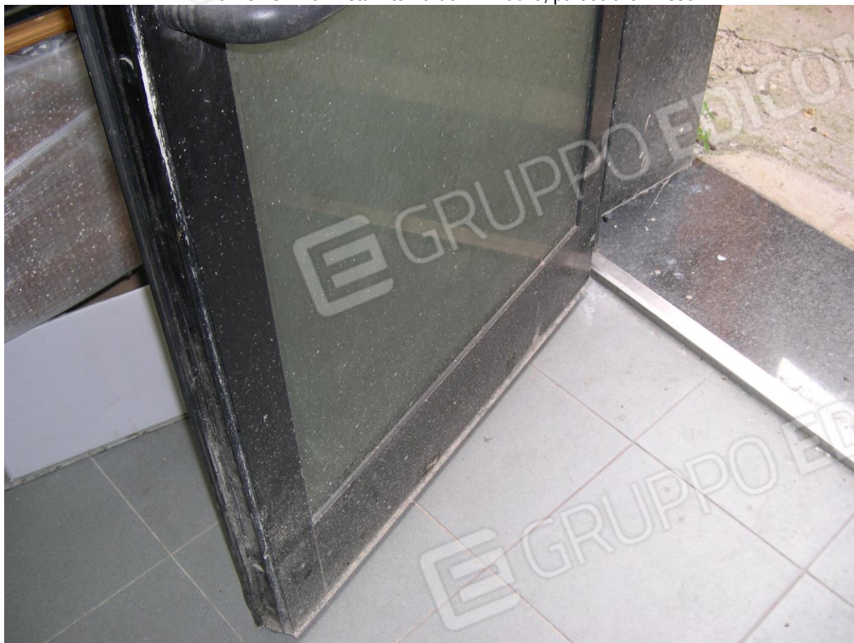
BENE 3 FOTO N°3: Vista interna dell'immobile, particolare infisso.
