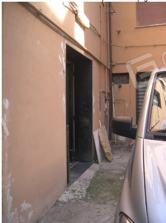
BENE 3 FOTO N°2: Prospetto Ovest (ingresso Sub 20).
