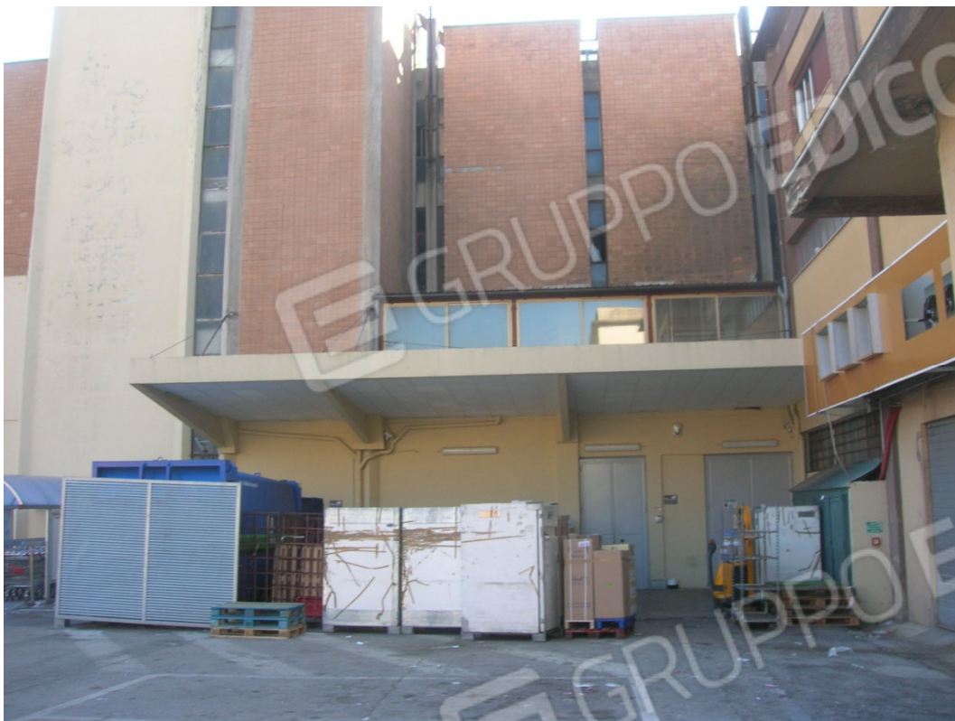
Zona di carico e scarico supermercato (sub 27)
