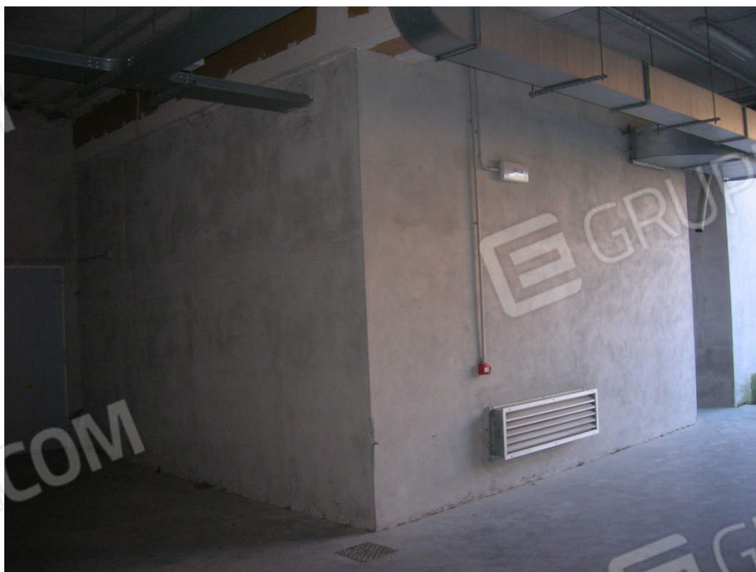
Locali piano secondo sottostrada sub 32 e 33
