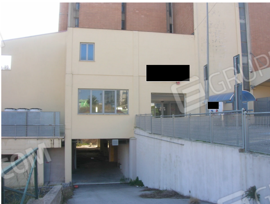
Accesso al piano secondo sottostrada (sub 29 e 27)
