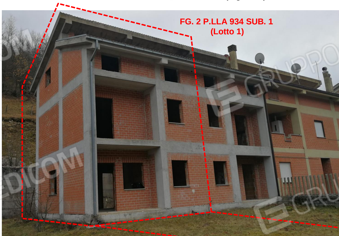
Foto 02 – Vista Esterna lato Ovest (Ingresso)
