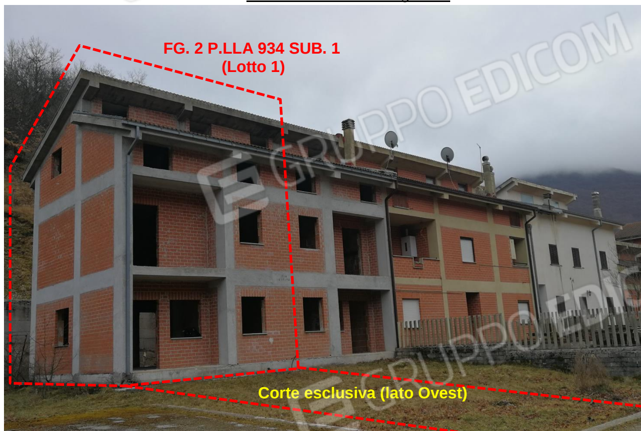
Foto 01 – Vista Esterna lato Ovest (Ingresso)
