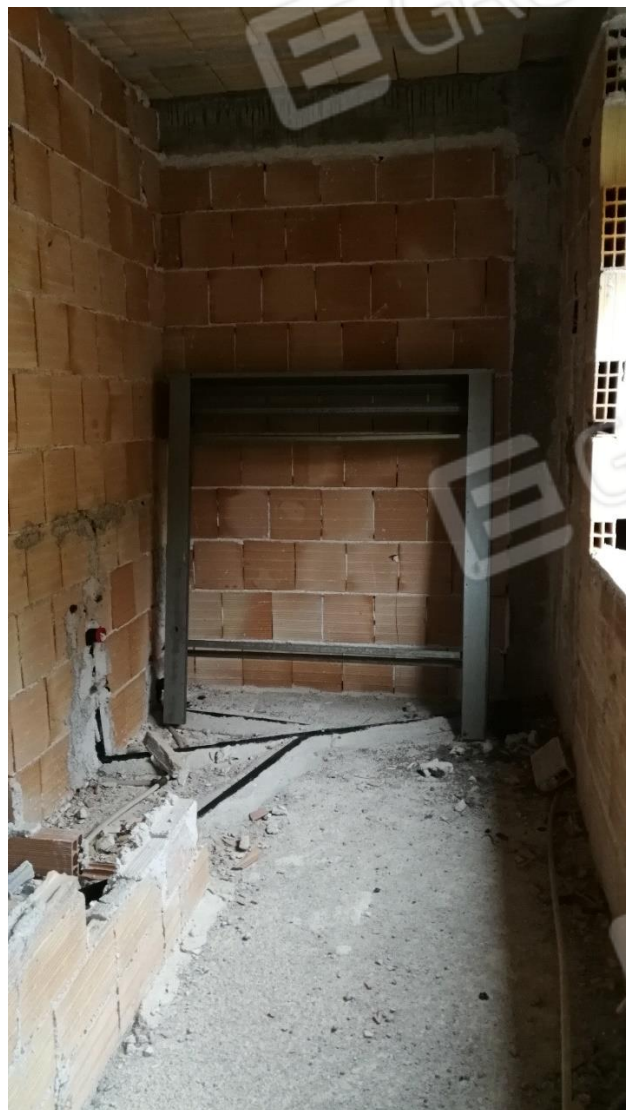
Foto 06 – Vano 04 (Piano Primo)
