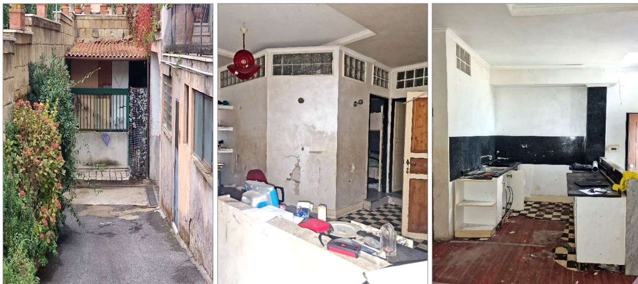
Foto della rampa condominiale e dell'appartamento
