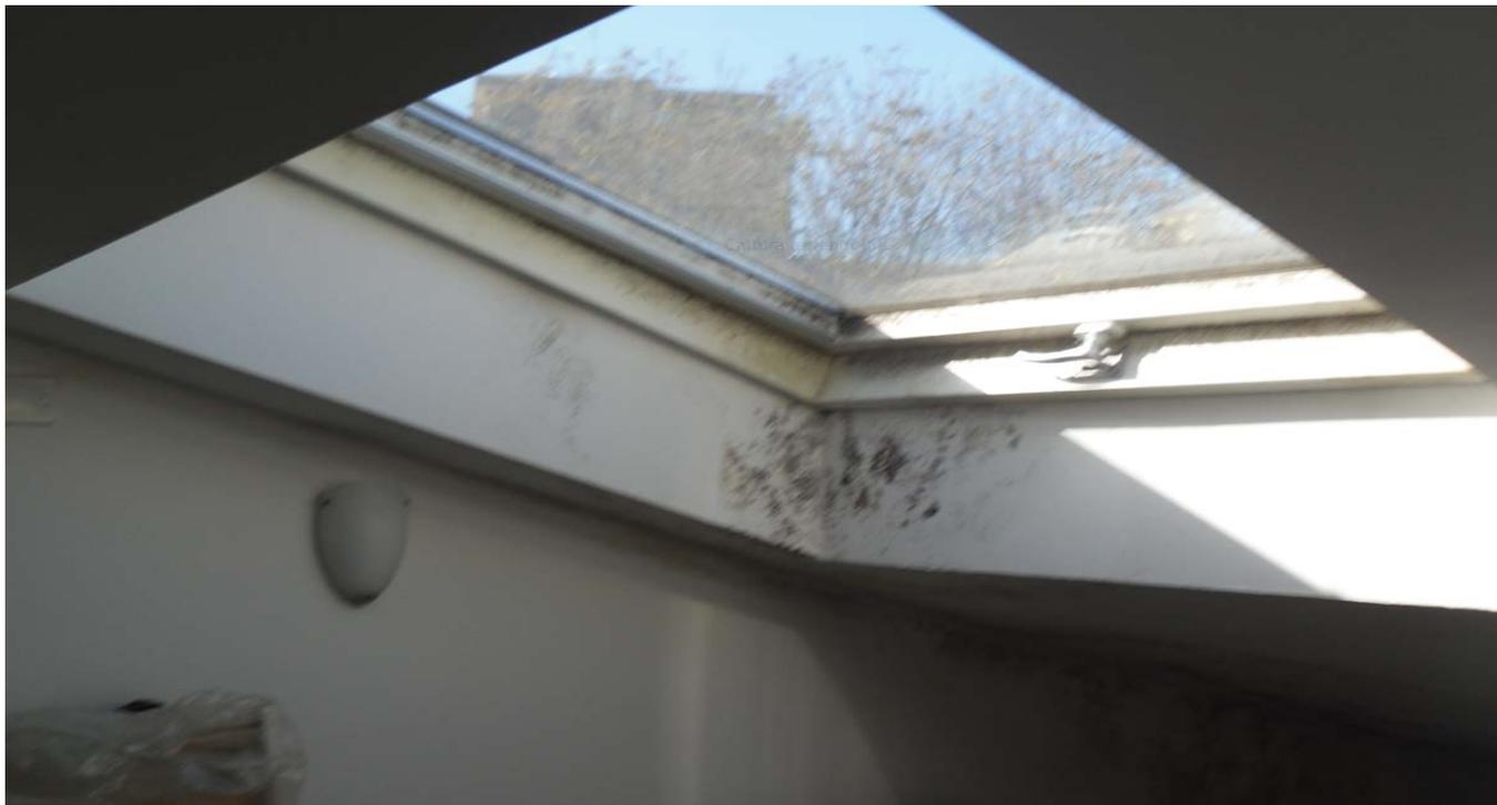
(FOTO INTERNA – INFILTRAZIONI DI ACQUA DAI LUCERNAI AL PIANO MANSARDA)
