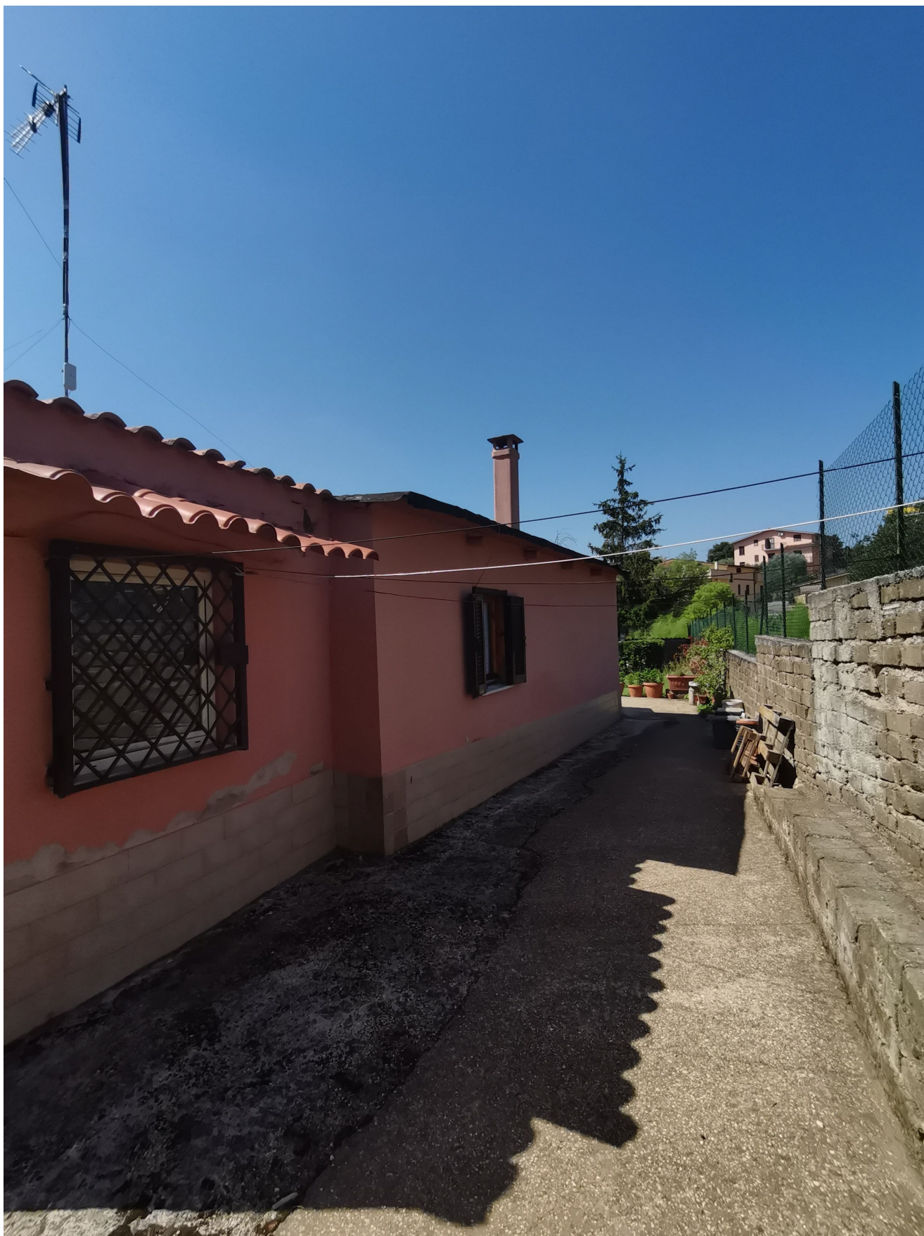
Vista esterna immobile dal distacco verso proprietà Comune di Roma
