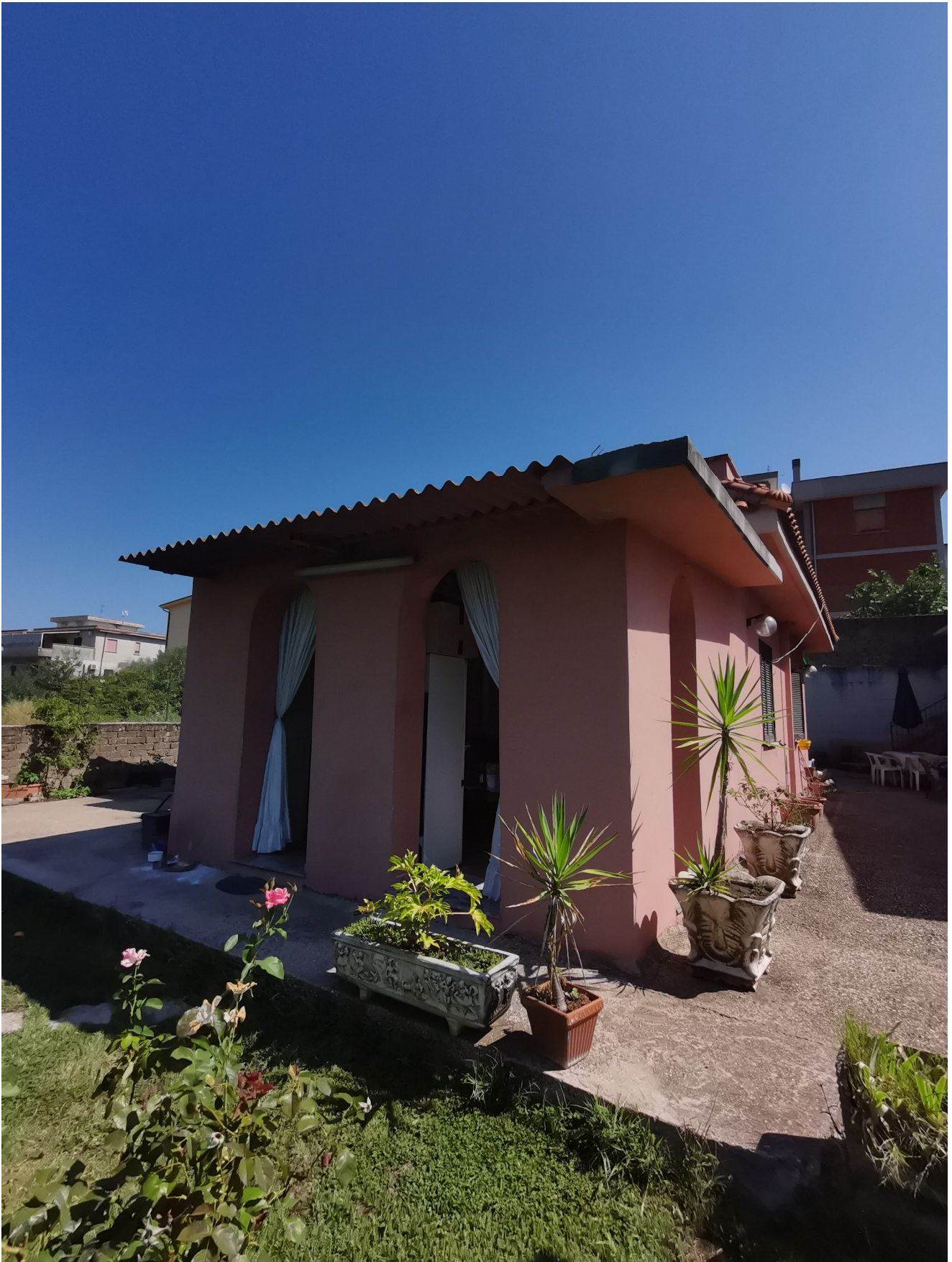
Vista esterna immobile dalla corte di pertinenza
