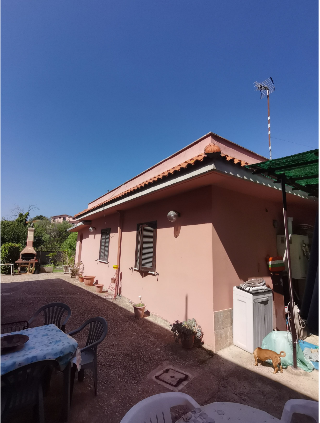
Vista esterna immobile dalla corte di pertinenza
