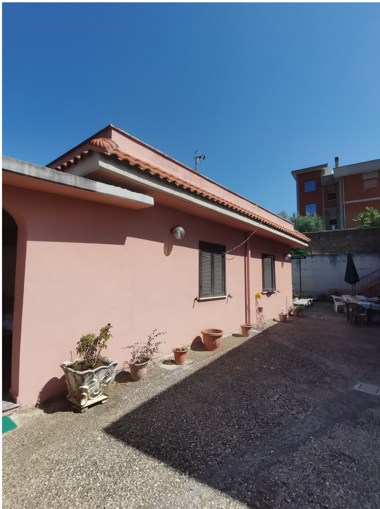
Vista esterna immobile dalla corte di pertinenza
