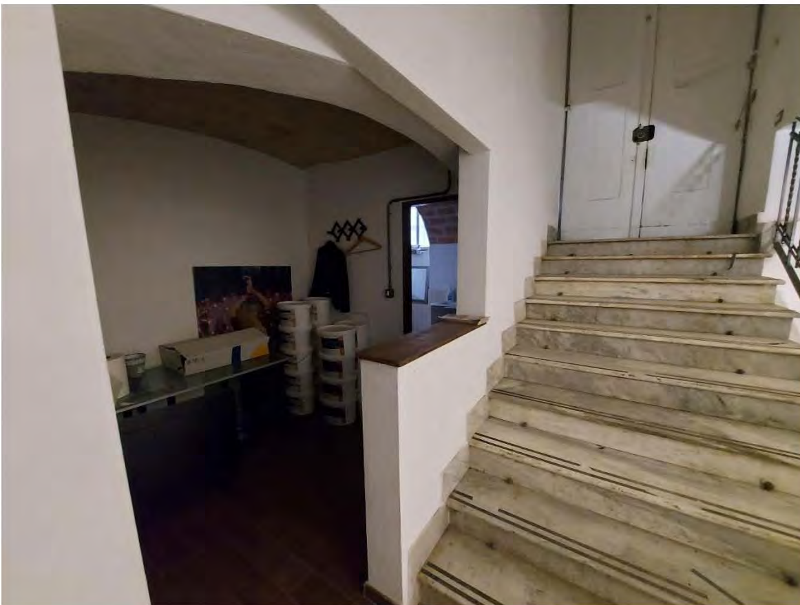
Interno del civico 27 dal primo pianerottolo scala verso l'ambiente "A"
