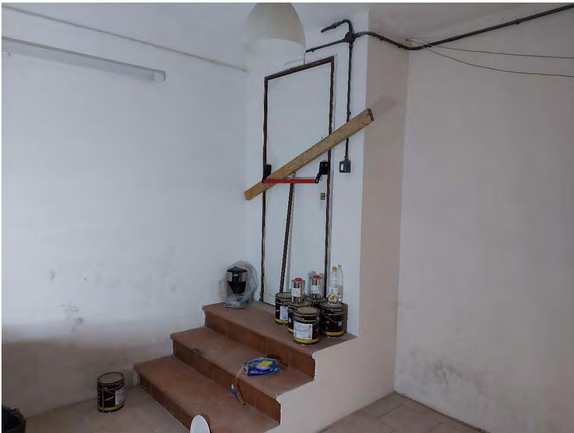
Accesso dal locale "H" a scala con sbarco androne condominiale scala su Via Ciro Menotti
