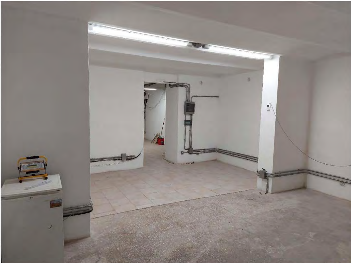
Locale "F" verso locale "G"
