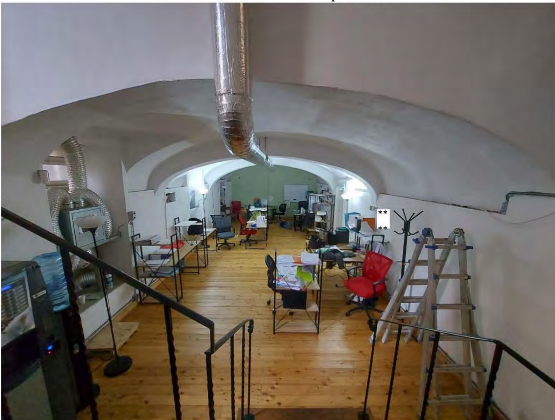
Locale sub. 540 al piano S1 dalla scala realizzata con il taglio del solaio
