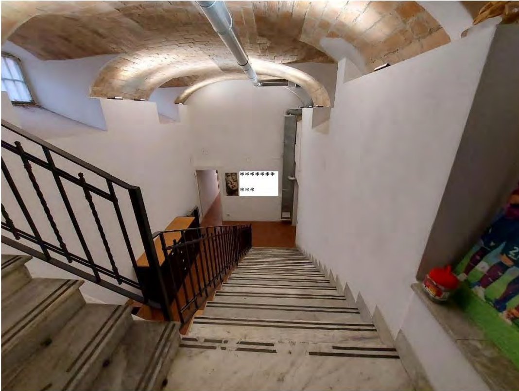
Dal pianerottolo della scala di accesso al civico 27 verso ambiente "B"
