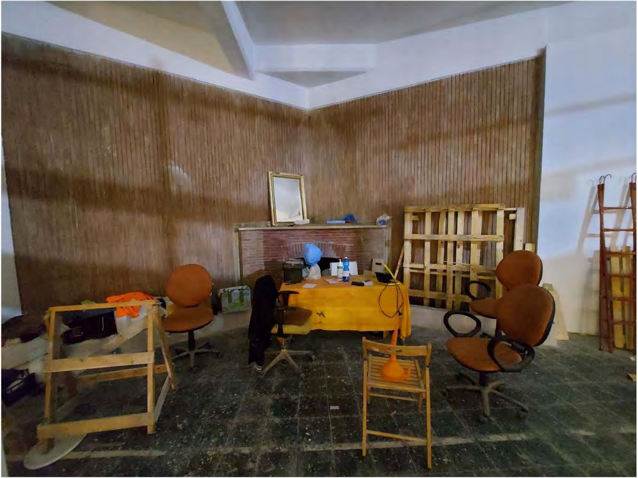
Locale "M" verso Via Avezzana – si nota la presenza di un camino che da notizie assunte non risulta più funzionante in quanto la canna fumaria sembrerebbe essere stata tombata
