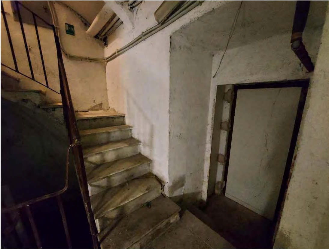
Scala al piano S2 con porta di accesso locale "H" con sbarco su androne scala Via Ciro Menotti 26
