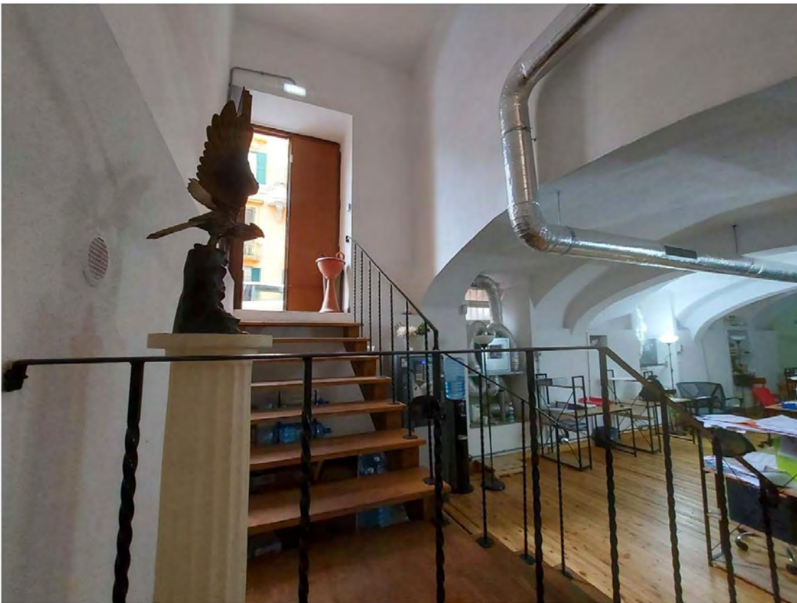
Scala realizzata con demolizione solaio del calpestio piano terra per accesso al piano S1 dal civico 25
