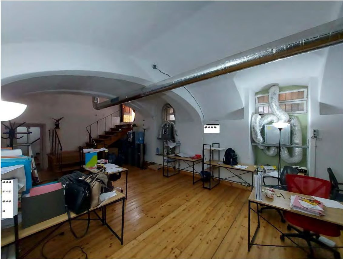
Locale sub. 540 al piano S1 verso la scala realizzata con il taglio del solaio
