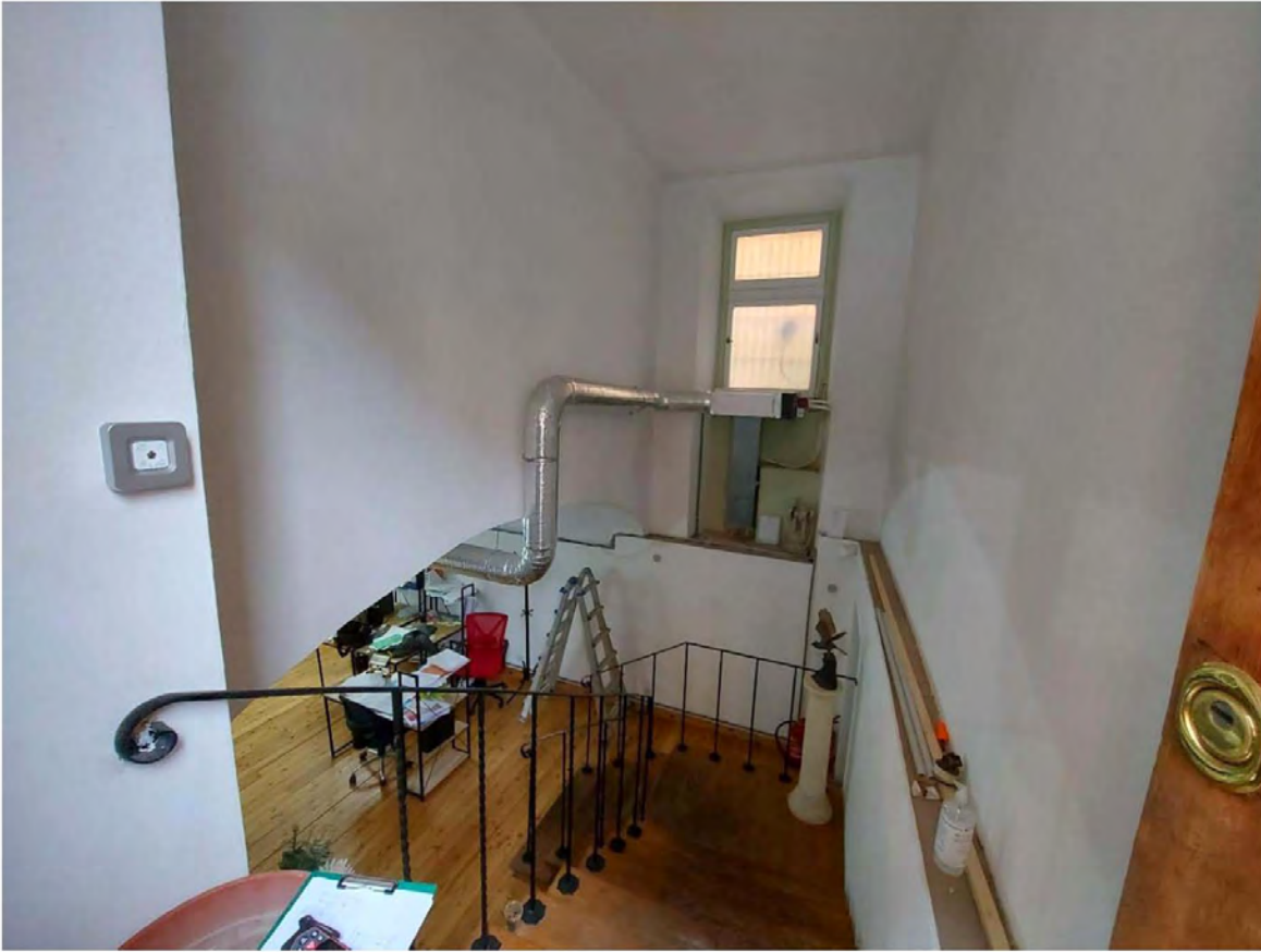
Scala realizzata con demolizione solaio per accesso al piano S1 dal civico 25 – si nota la finestra che in precedenza aveva il servizio igienico
