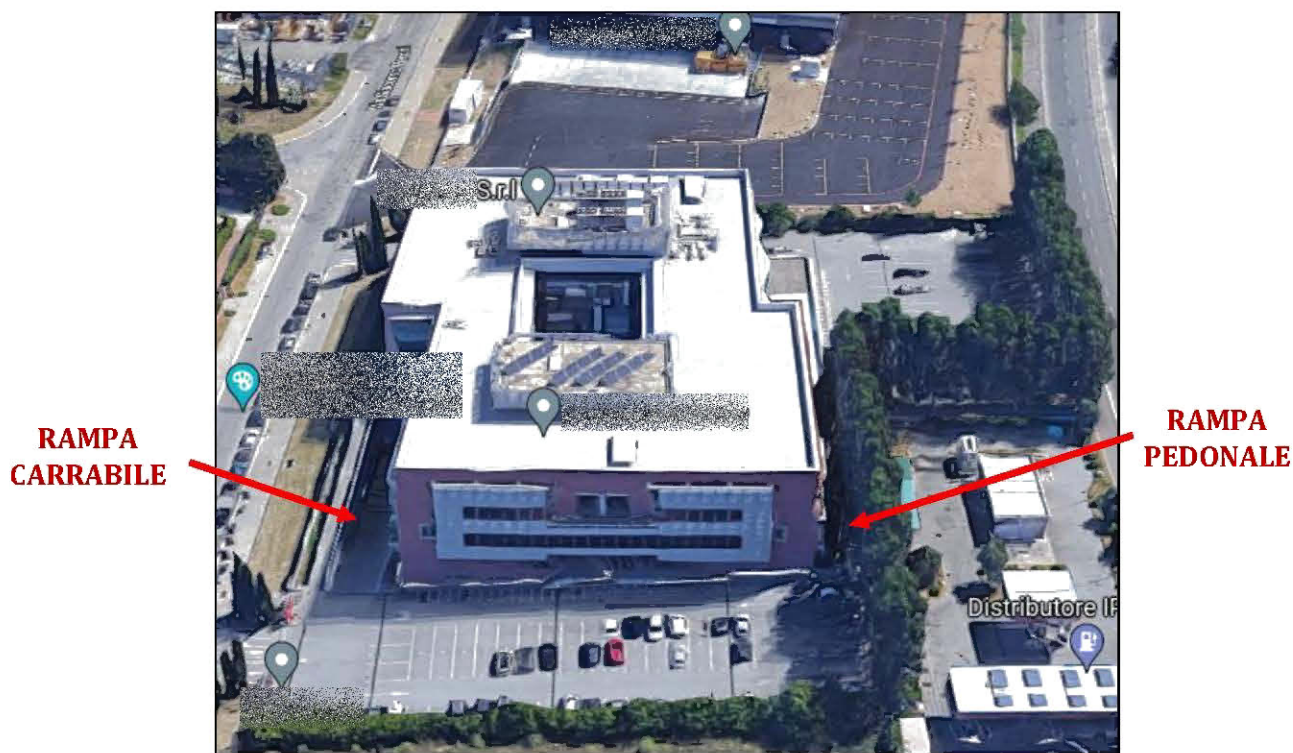
Vista satellitare 3D con individuazione della rampa carrabile e della rampa pedonale
