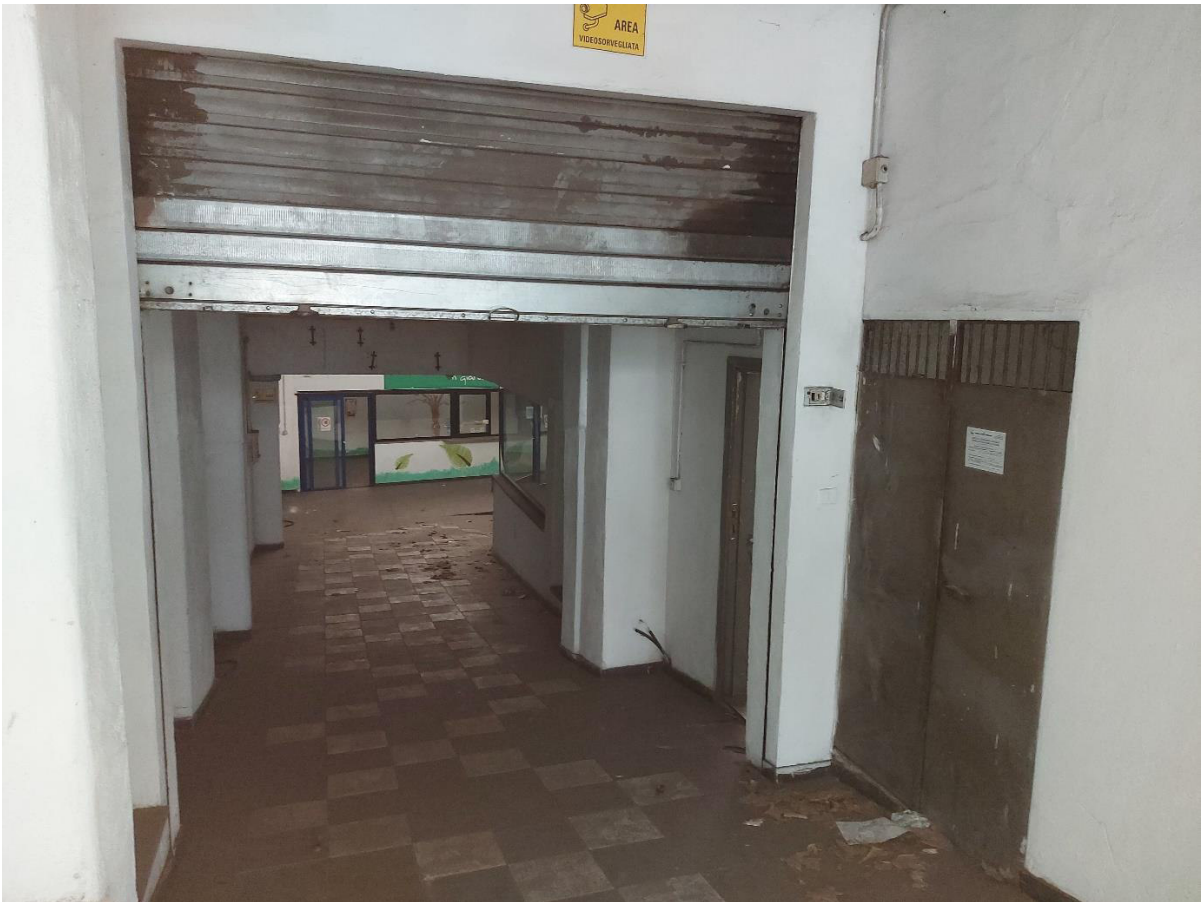
Rampa su Via di Casal Bertone
