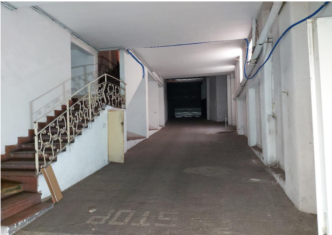
Rampa su Via Asinari Di San Marzano
