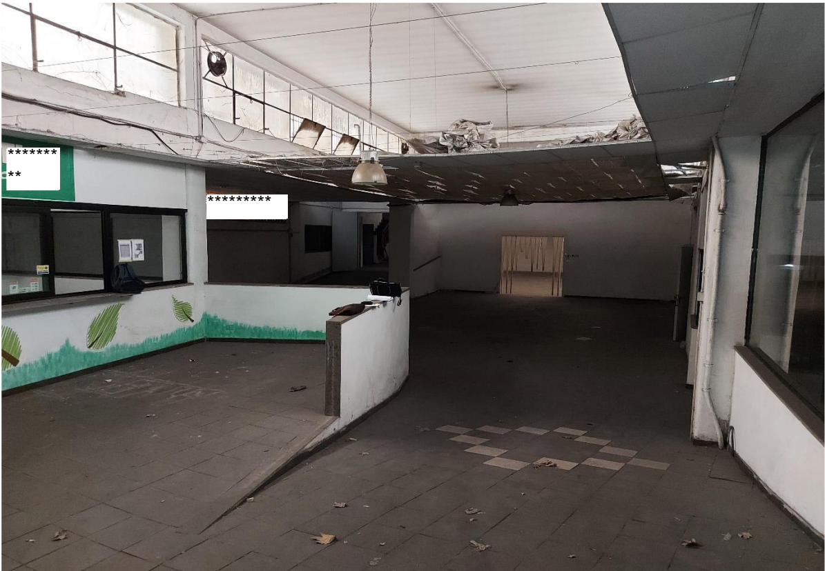
Da rampa via Casal Bertone verso locale 1
