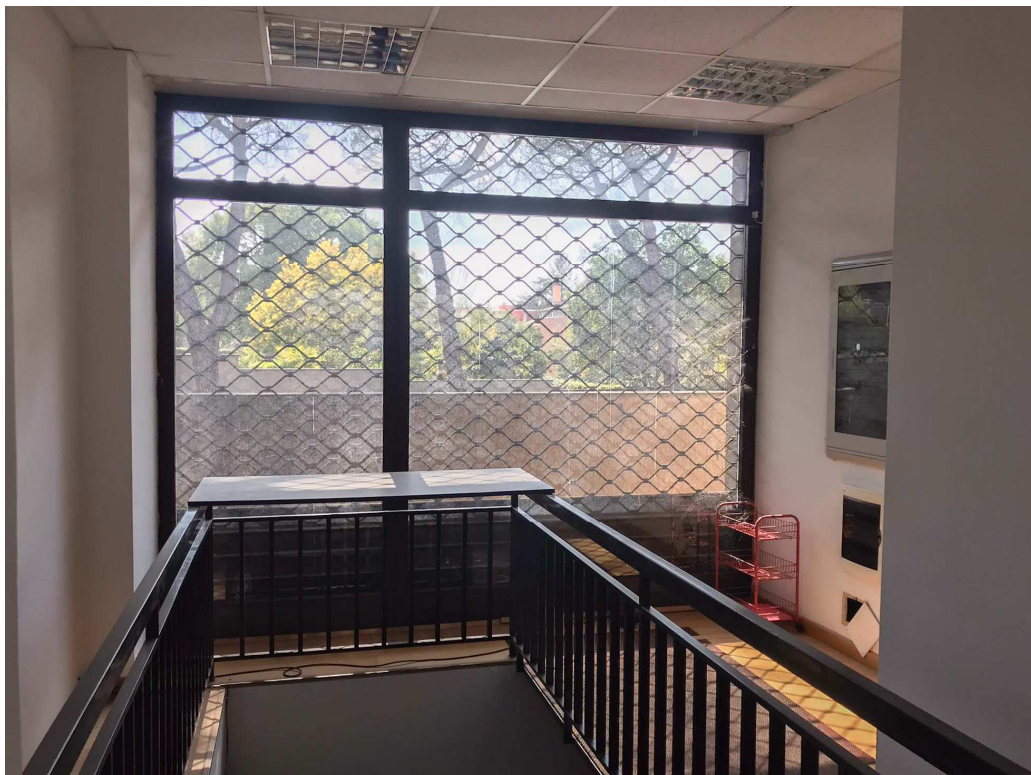
Foto Negozio - vano scala (Fotografie complete in allegati)
