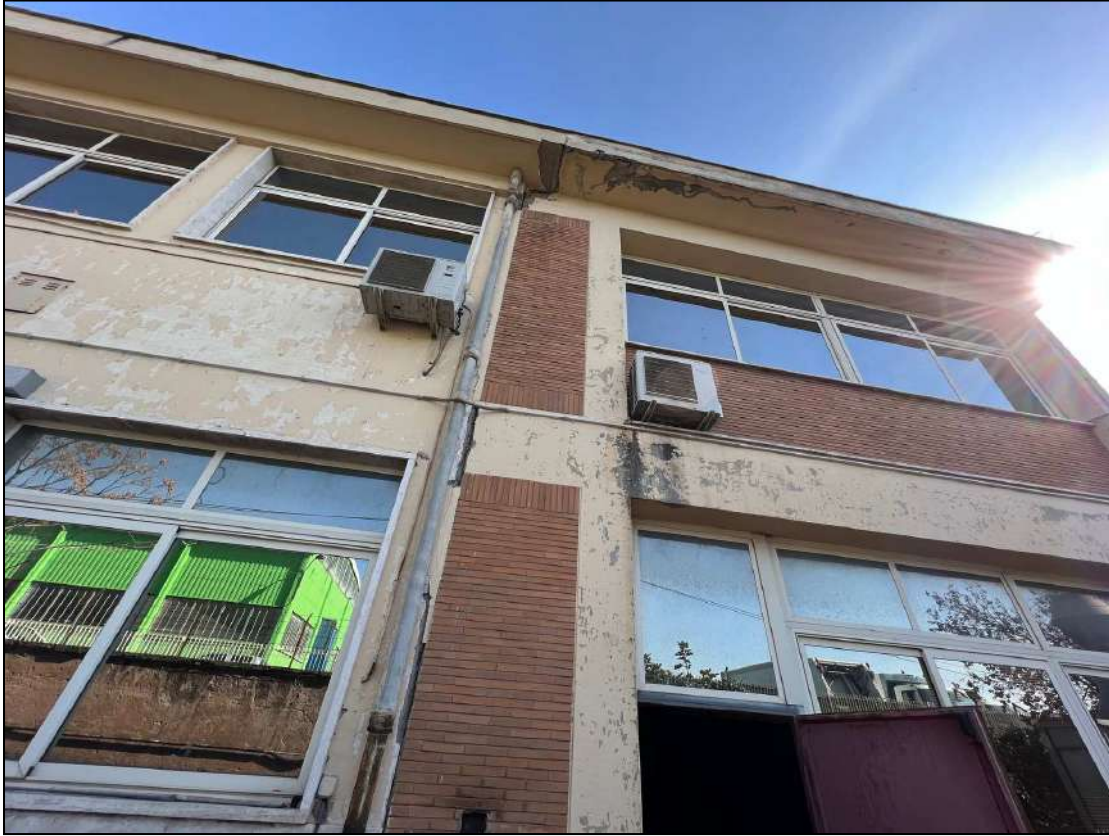
Stato conservativo della facciata con vista dalla corte retrostante l'edificio
