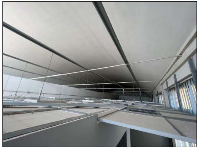
Vista della copertura con volta a botte
