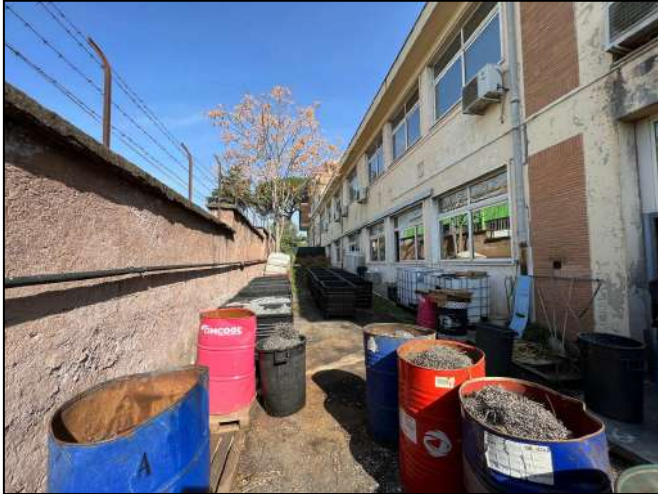
Corte esterna retrostante
