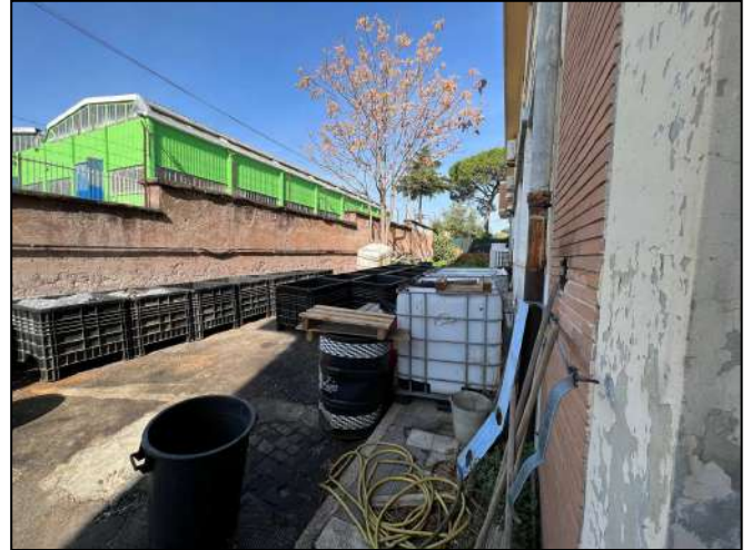
Corte esterna retrostante
