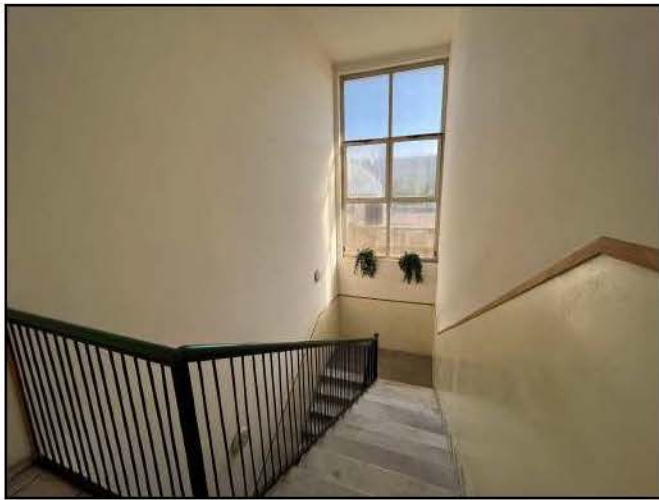
Scala di accesso al primo piano - censita come B.C.N.C. Fg 294, part. 530, sub. 595
