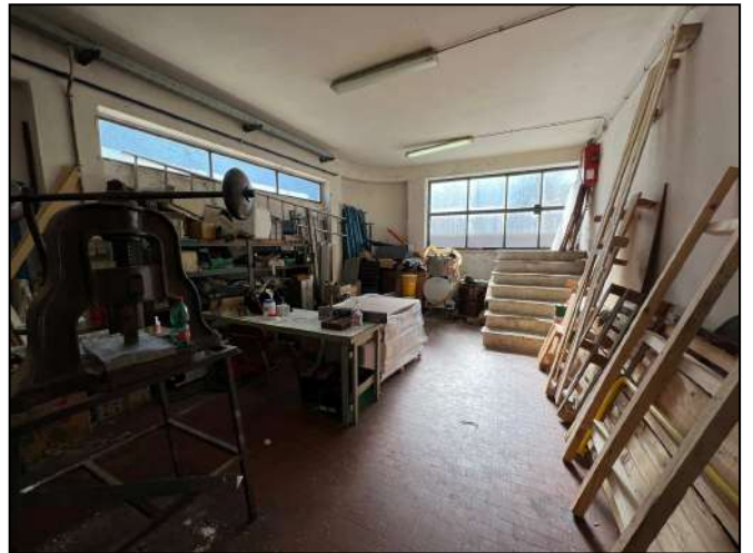
Vista delle scale di collegamento con l'esterno su part. 519 di altra proprietà (servitù di passaggio)
