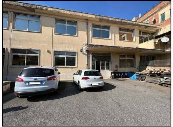
Vista esterna del fabbricato industriale
