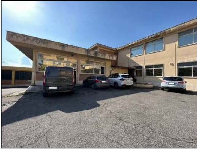
Vista esterna del fabbricato industriale
