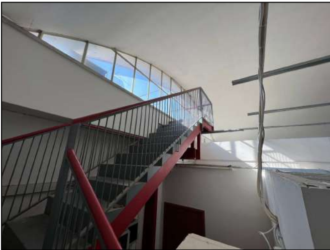
Scala di accesso alla copertura praticabile
