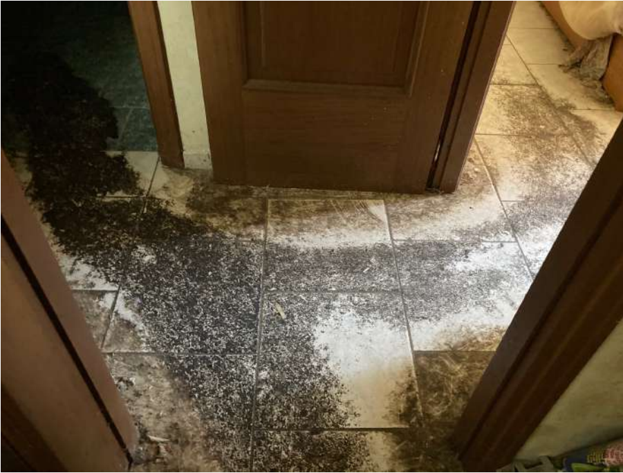
STATO CONSERVATIVO FINITURE – pavimentazione disimpegno.
