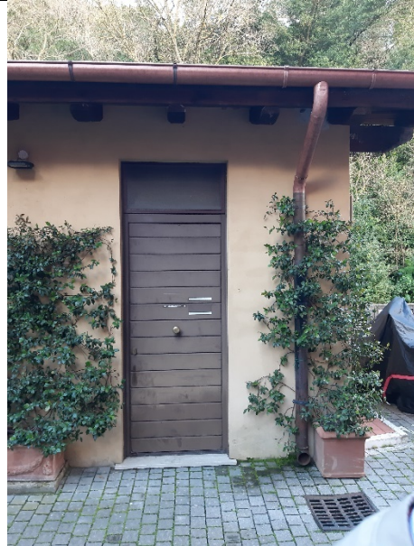
Foto 3: prospetto primo ingresso
