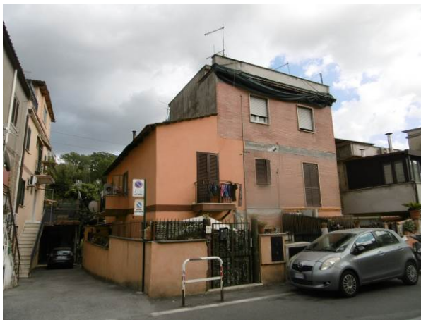
Vista da strada
