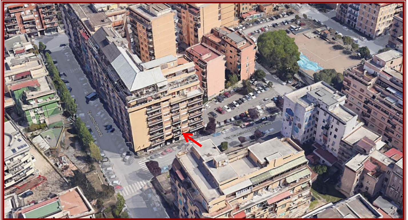
Vista 3D da Google Earth – Inquadratura dell'appartamento con accesso su Via Bartolomeo Perestrello, 116
