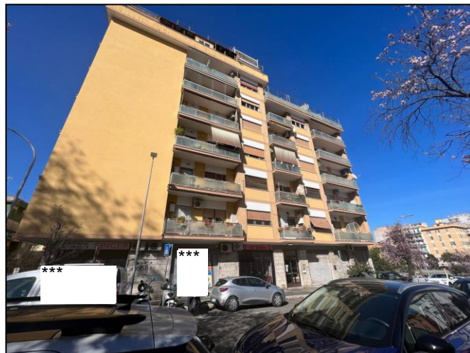
Vista del fabbricato su Via Bartolomeo Perestrello
